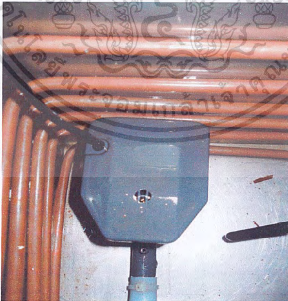
รูปที่ 3.19 การติดตั้งปั๊มแบบจุ่มน้ำ
