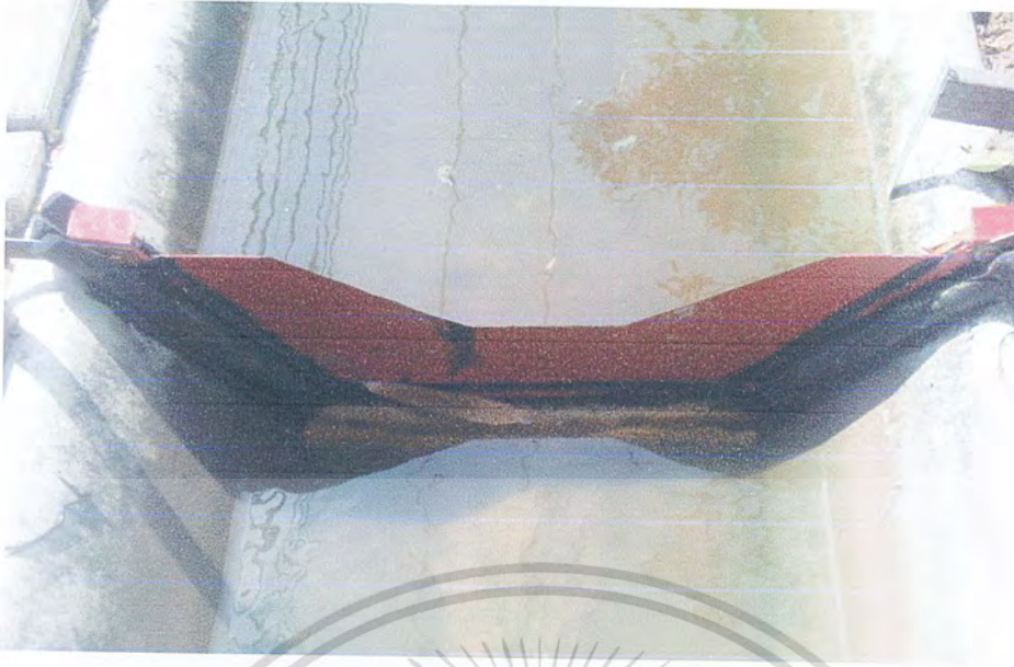
รูปที่ ๓.3 การติดตั้งฝายสี่เหลี่ยมคางหมู
