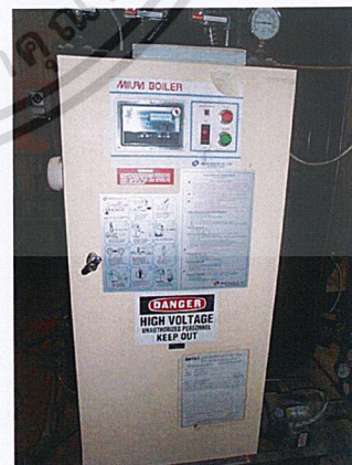
รูปที่ 2. 35 หม้อไอน้ำแบบไหลผ่านครั้งเดียวตลอด [19]
