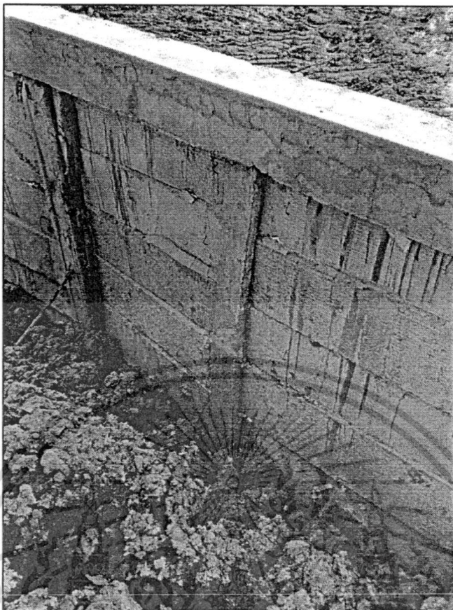
รูปที่ 3.19 สภาพรอยแตกร้าวที่เกิดขึ้นกับเสาเข็ม
