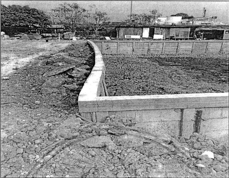
รูปที่ 3.21 การโค้งตัวในคานยาวของบ่อบำบัดน้ำเสีย
