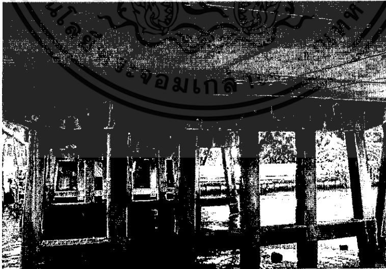
รูปที่ 16 แสดงภาพความยาวช่วงสะพาน และพื้นสะพาน (Deck) ซึ่งเป็นพื้น RC Slab ของสะพานข้ามคลองพระ โขนง 17
