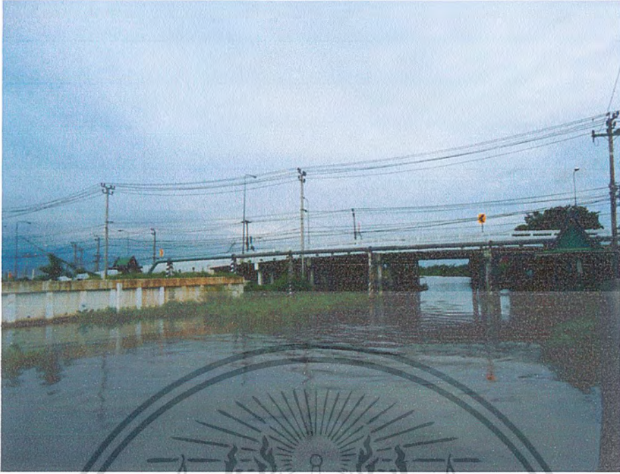
รูปที่ 5.4. สะพานข้ามคลองหนองท่า อยู่บนถนนวัดศรีวารีน้อย บริเวณโค้งวัดหัวคู
