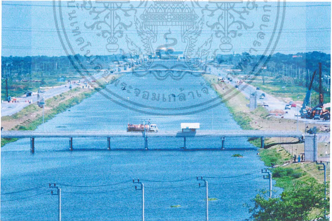
รูปที่ 3.13. คลองระบายน้ำโครงการระบายน้ำบริเวณสนามบินสุวรรณภูมิ
