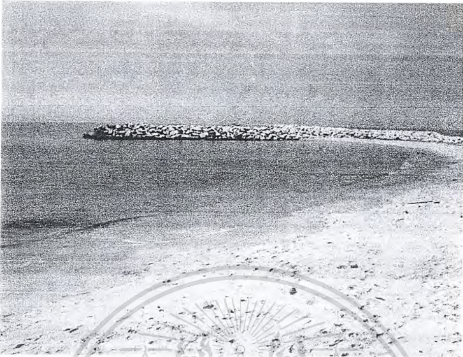
รูปที่ 4.10 สภาพชายหาดที่ถูกกัดเซาะ หลังเขื่อน groin ฝั่งตะวันออก
