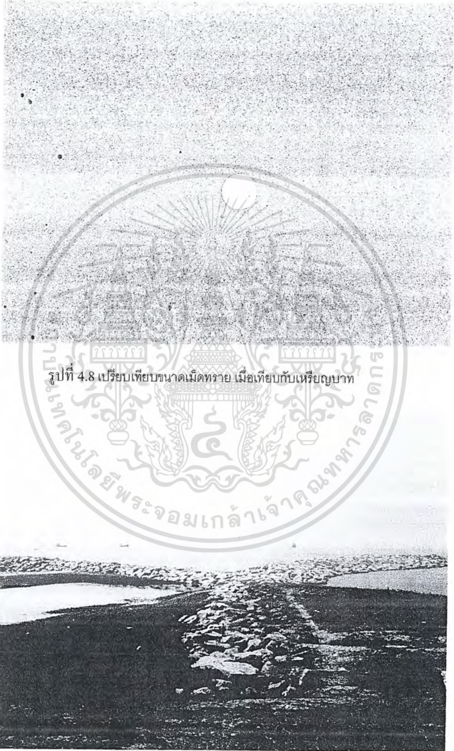
รูปที่ 4.9 เปรียบเทียบสภาพชายหาด หลังเขื่อน groin ฝั่งตะวันตก และฝั่งตะวันออก
