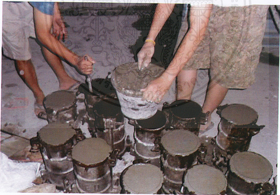
รูปที่ ผก.2. เทคอนกรีตใส่แบบหล่อ
