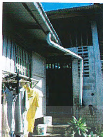
รูปที่ 6.1. รางรับน้ำฝนจากหลังคา
