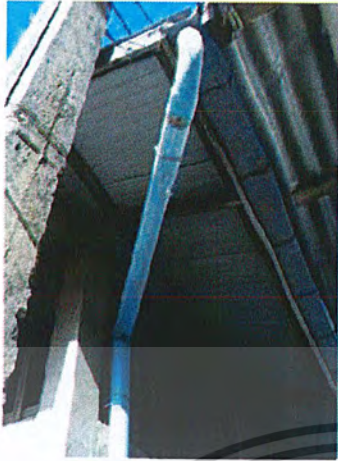
รูปที่ ผ.จ.1. รางรับน้ำฝนจากหลังคา
