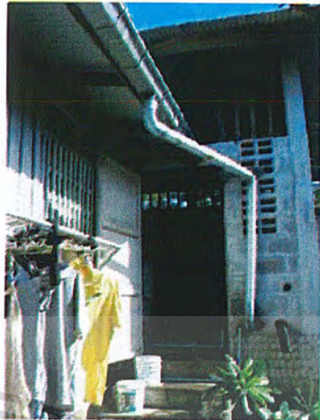
รูปที่ ผ.จ.1. รางรับน้ำฝนจากหลังคา
