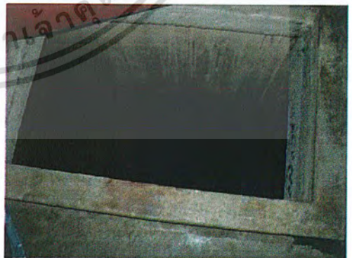
รูปที่ ผ.จ.3. บ่อกักเก็บน้ำฝน
