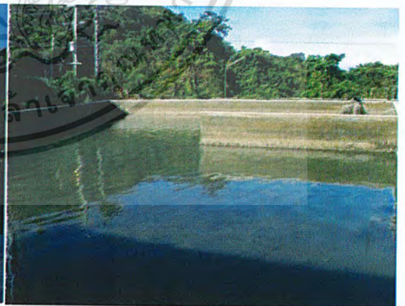
(b) บ่อพักน้ำที่สูบน้ำจากน้ำทะเล
