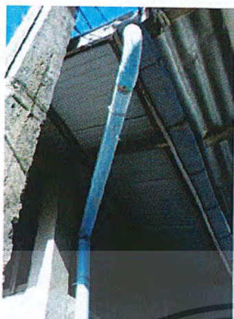
รูปที่ 6.1. รางรับน้ำฝนจากหลังคา
