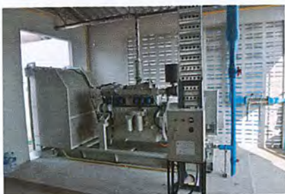
รูปที่ 14 เครื่องกำเนิดไฟฟ้าภายในโรงไฟฟ้าชีวมวล
