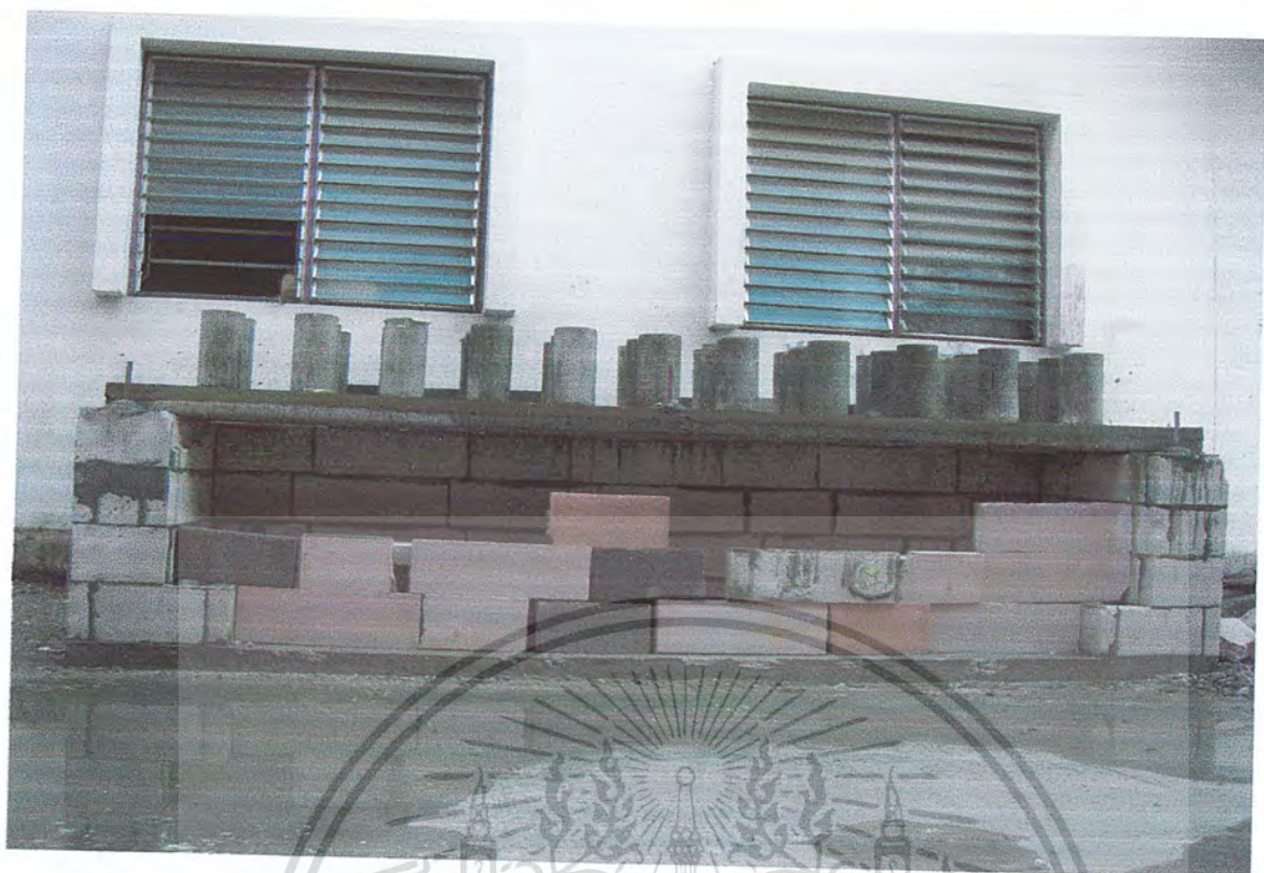
รูปที่ ผจ3:แสดงลักษณะการวิบัติของพื้นคอนกรีตอัดแรงหลังเผาที่ระยะเปลวไฟถึงท้องพื้น 30 ซม.
