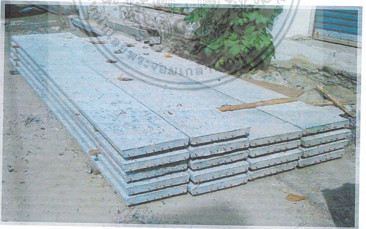
เอกสารนี้ รูปที่ ผล2:แสดงพื้นคอนกรีตอัดแรงที่ใช้ในการทดสอบผลิตภัณฑ์ของเพลิงไหม้ ประโยชน์ด้านการค้า ไม่ว่ากรณีใดๆ ทั้งสิ้น อีกทั้งห้ามมิให้ดัดแปลงเนื้อหา และต้องอ้างอิงถึงเจ้าของเอกสารทุกครั้งที่มีการนำไปใช้
