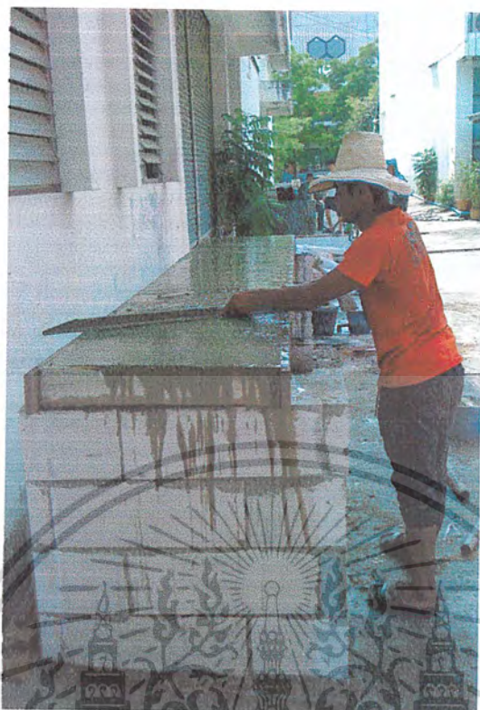
รูปที่ ผง7:แสดงการปาดหน้าคอนกรีตทับหน้าพื้นคอนกรีตอัดแรง
