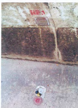
รูป 6.36 หมุดหลักฐานบริเวณ ถนนลาดกระบัง ซอย 40
