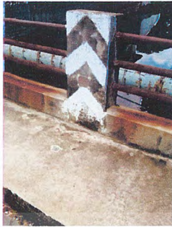
รูป 6.31 หมุดหลักฐานบริเวณ ถนนนวมินทร์ ซอย 74
