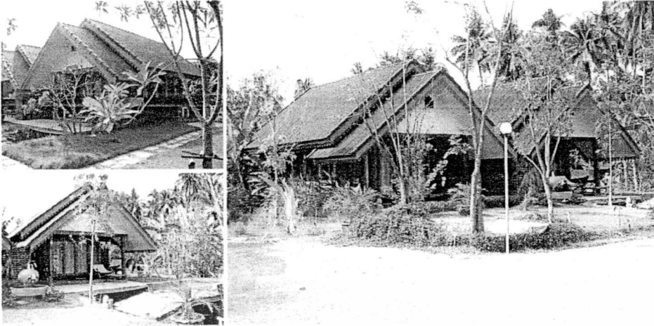
ภาพที่ 4.52 แสดงรูปลักษณ์และภาพลักษณ์ทางสถาปัตยกรรม อาคารบ้านใหม่ในสวน
