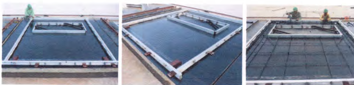
รูปที่ 5.9 แสดงแบบหล่ออะลูมิเนียม ที่และบมจ. พร็อพเพอร์ตี้ เพอร์เฟคใช้
