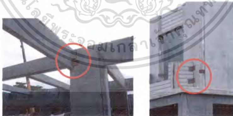
รูปที่ 4.123 แสดงรอยต่อแบบที่เป็นเหล็ก Plate โดยการเชื่อมเหล็กเข้าด้วยกัน (ที่มา:เอกสารประกอบการเข้าเยี่ยมชมโรงงานการผลิต วันที่ 17 ตุลาคม 2553)
