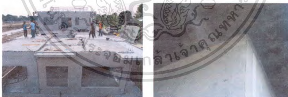
รูปที่ 4.89 แสดงการติดตั้งพื้นสำเร็จรูปหล่อจากโรงงานของชั้นบนและจุดเชื่อมยึดระหว่างผนัง (ที่มา:เอกสารประกอบการเข้าเยี่ยมชมโรงงานการผลิต วันที่ 20 ตุลาคม 2553)
