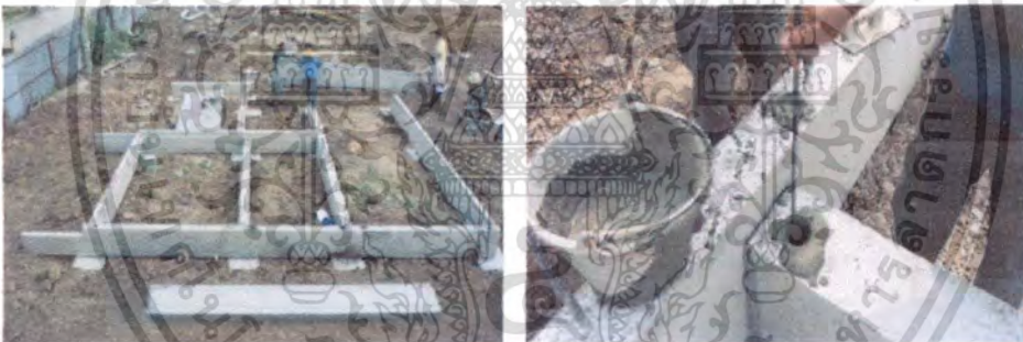
รูปที่ 4.84 แสดงงานเตรียมฐานรากและการเกร้าที่ปูนลงในช่องรอยต่อ (ที่มา:เอกสารประกอบการเข้าเยี่ยมชมโรงงานการผลิต วันที่ 20 ตุลาคม 2553)
