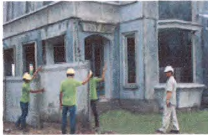
รูปที่ 4.130 แสดงการติดตั้งงานรั้วสำเร็จรูป
