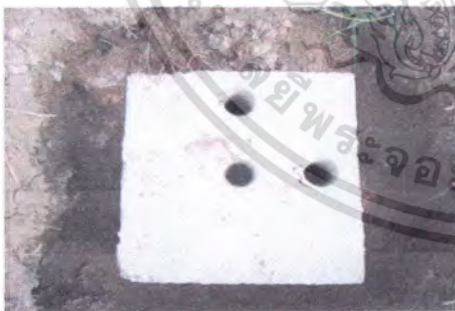
รูปที่ 4.51 แสดง FOOTING มีไว้สำหรับเสียบเหล็กเสริม ขนาด DB.12 มม.
