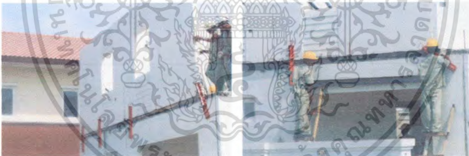
รูปที่ 4.157 แสดงการติดตั้งชิ้นส่วนผนังโดยทีมช่างของพกฯเอง
