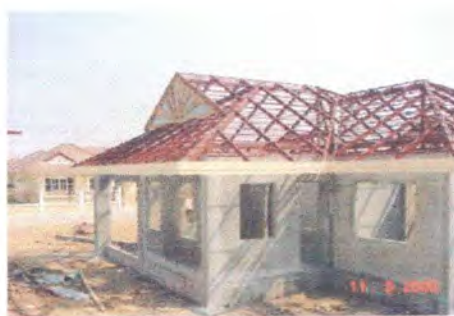
รูปที่ 4.64 แสดงการติดตั้งโครงสร้างงานหลังคา
