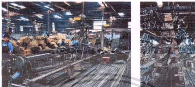
รูปที่ 4.36 แสดงโรงเหล็กภายในโรงงานการผลิตชิ้นส่วนที่ออนนุช
