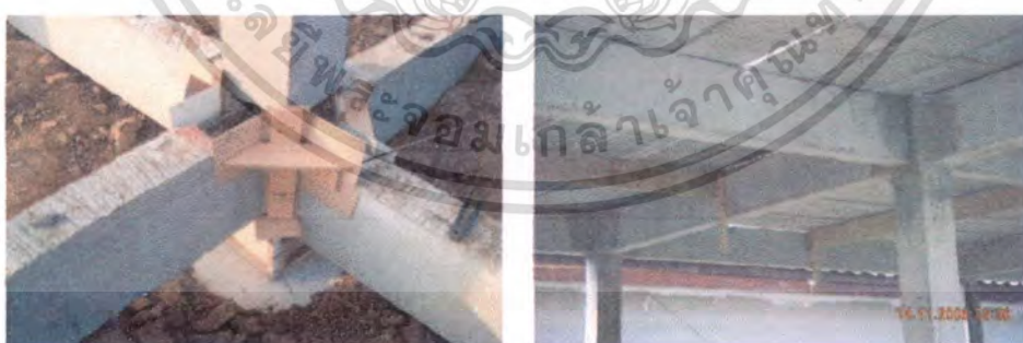
รูปที่ 4.19 แสดงการเข้าไม้แบบเกร้าท์ปูนปิดรอยต่อระหว่างชิ้นส่วนเสากับคาน
