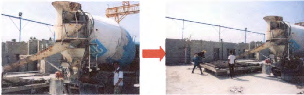
รูปที่ 5.26 แสดงการไหลลดคอนกรีตเข้าสู่ line การผลิตของ บริษัทผู้ผลิตชิ้นส่วนให้กับ บมจ. พร็อพเพอร์ตี้ เพอร์เฟค โดยไม่ผ่านถังปูน
