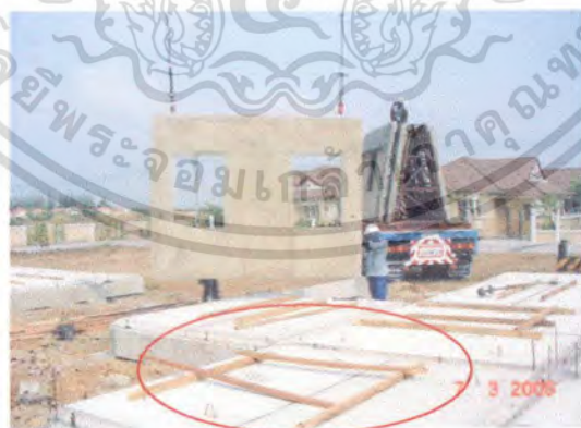
รูปที่ 4.55 แสดงไม้ที่ทำการยึดแผ่นพื้นกับผนัง
