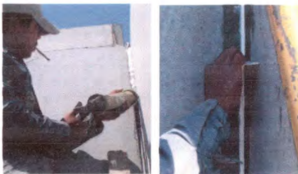
รูปที่ 4.127 แสดงการทำหรือยิง โพลียูรีเทนเข้าไปอีกชั้นหนึ่ง เพื่อป้องกันการรั่วซึมของน้ำ (ที่มา:เอกสารประกอบการเข้าเยี่ยมชมโรงงานการผลิต วันที่ 17 ตุลาคม 2553)
