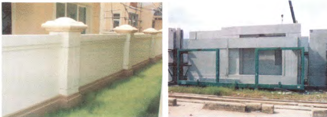
รูปที่ 4.139 แสดงชิ้นส่วนของรั้วลำเรือรูป(ซ้าย) และ ผนัง(ขวา) ที่ทำการผลิตในปัจจุบัน (ที่มา:เอกสารประกอบการเข้าเยี่ยมชมโรงงานการผลิต วันที่ 17 ตุลาคม 2553)
