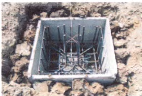
รูปที่ 4.16 แสดงขั้นตอนการหล่อฐานราก
