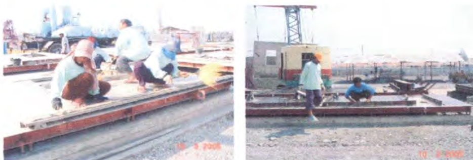
รูปที่ 4.46 แสดงแรงงานที่กำลังผูกเหล็กเสริม
