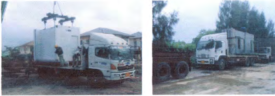
รูปที่ 4.156 แสดงการขนส่งชิ้นส่วนโดยรถเทรลเลอร์และรถบรรทุก
