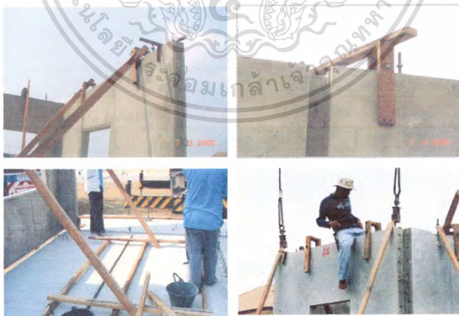
รูปที่ 4.59 แสดงประกับไม้เนื้อแข็งขนาด 1x1/2" x 3"
