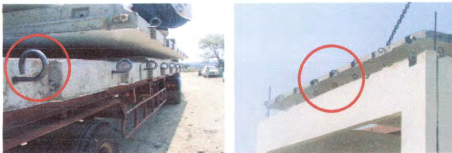
รูปที่ 4.124 แสดงชิ้นส่วนที่ใช้รอยต่อแบบฝังห่วง (ที่มา:เอกสารประกอบการเข้าเยี่ยมชมโรงงานการผลิต วันที่ 17 ตุลาคม 2553)
