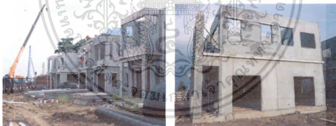
รูปที่ 4.134 แสดงการติดตั้งผนังชั้นบน
