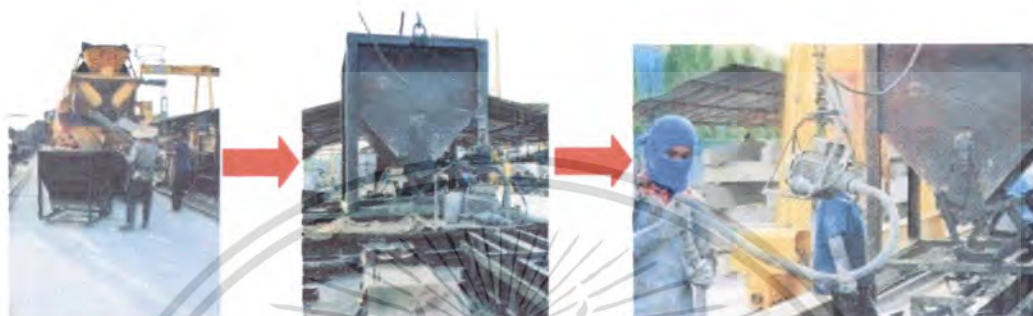
รูปที่ 5.24 แสดงการไหลตคอนกรีตเข้าสู่ line การผลิตของ บริษัทซีคอน จำกัด คอนกรีตสำเร็จรูปจากรถปูนจะถูกไหลลงถังปูน (Bucket) แล้วจึงเทลงสู่แบบหล่อ
