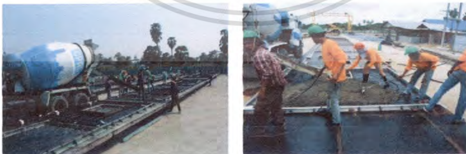
รูปที่ 4.80 แสดงการเทคอนกรีตจากรถปูนผสมเสร็จและการเกลี่ยคอนกรีตลงแบบหล่อ (ที่มา:เอกสารประกอบการเข้าเยี่ยมชมโรงงานการผลิต วันที่ 20 ตุลาคม 2553)
