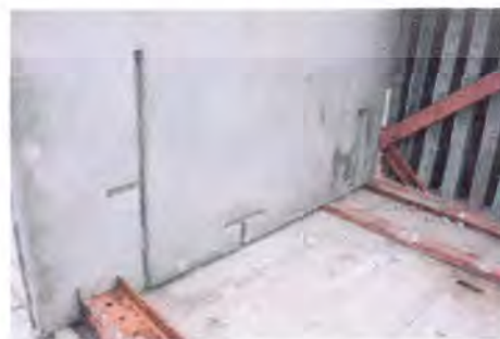
รูปที่ 4.43 แสดงชิ้นส่วนในขณะติดตั้งประกอบหน้างานและชิ้นส่วนที่ถูกออกแบบไว้สำหรับการ
