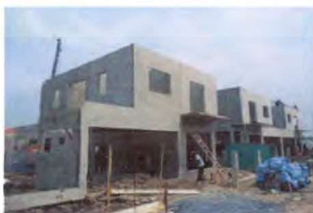
รูปที่ 4.77 แสดงตัวอย่างบ้านในระบบการก่อสร้างแบบผนังรับน้ำหนัก
