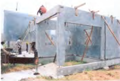
รูปที่ 4.43 แสดงชิ้นส่วนในขณะติดตั้งประกอบหน้างานและชิ้นส่วนที่ถูกออกแบบไว้สำหรับการ
