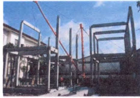
รูปที่ 5.20 แสดงการติดตั้งชิ้นส่วนด้วยกระโดงเครน
