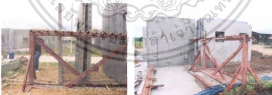
รูปที่ 4.73 แสดงชิ้นส่วนสำเร็จรูปที่รอขนส่งไปติดตั้งยังหน้างาน
