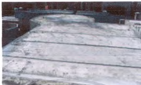
รูปที่ 4.133 แสดงการติดตั้งแผ่นพื้นชั้นบน
