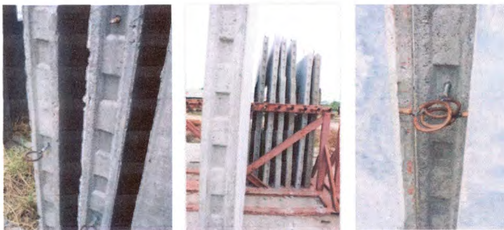
รูปที่ 4.44 แสดง Inter lock การออกแบบ Shear Key ระหว่างแผ่นชั้นส่วนเพื่อเพิ่มแรงเสียดทาน
