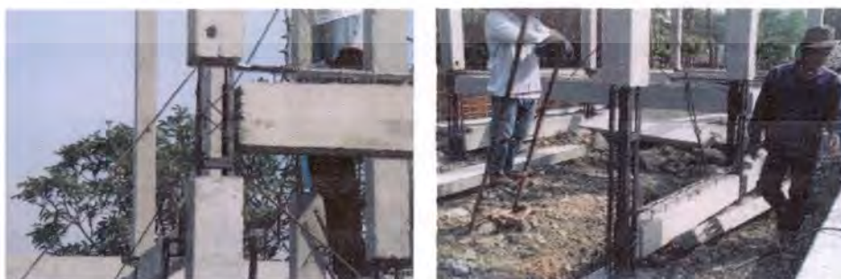
รูปที่ 4.13 แสดง joint ในการเชื่อมชิ้นส่วนเข้าด้วยกัน
