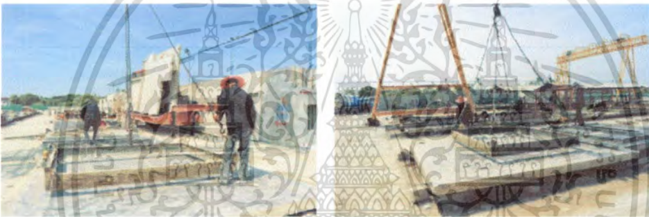
รูปที่ 4.105 แสดงการใช้งาน Gantry Crane สำหรับเคลื่อนย้ายชิ้นส่วน
