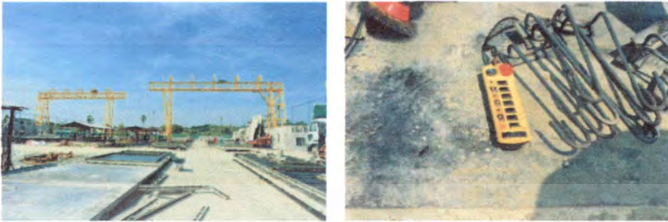
รูปที่ 4.104 แสดง Gantry Crane และรีโมทสำหรับบังคับเครน
