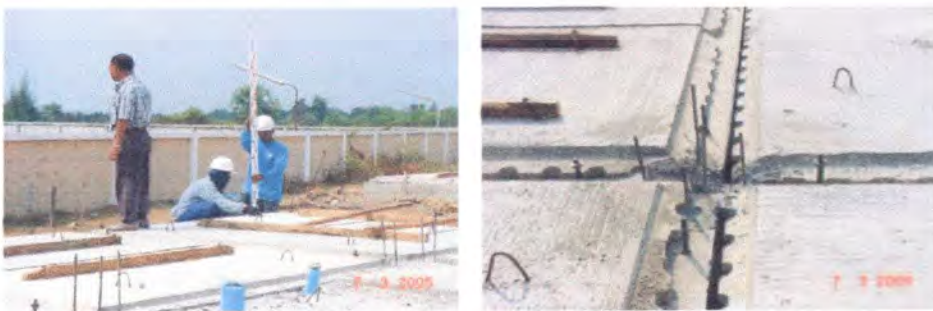
รูปที่ 4.53 แสดงขั้นตอนการติดตั้งพื้นชั้นหนึ่ง
