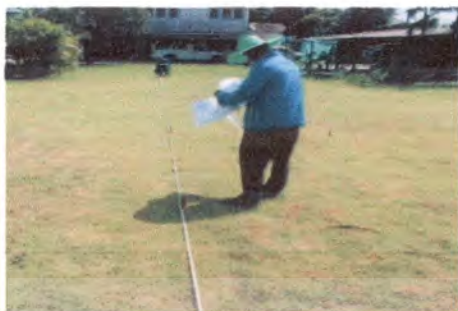
รูปที่ 4.14 แสดงขั้นตอนการวางผัง
