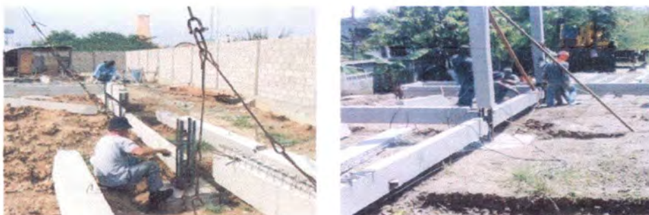
รูปที่ 4.17 แสดงติดตั้งงานโครงสร้าง ฐานรากและชิ้นส่วนสำเร็จรูปชั้นล่าง
