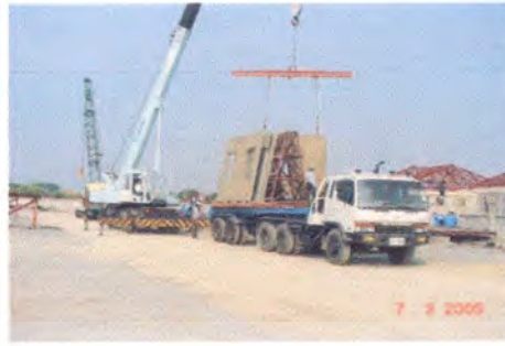
รูปที่ 4.50 แสดงการยกชิ้นส่วนขึ้นสู่รถบรรทุก
