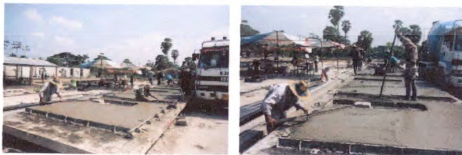
รูปที่ 5.11 แสดงการใช้แรงงานคนและเครื่องขัดผิวหน้าชิ้นส่วนของบริษัทผู้ผลิตชิ้นส่วนให้กับ บมจ. พร็อพเพอร์ตี้ เพอร์เฟค
