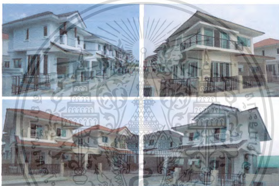
รูปที่ 4.93 แสดงขั้นตอนการตกแต่งและการเก็บงานขั้นสุดท้าย
