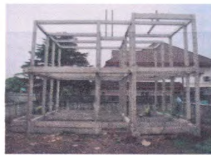
รูปที่ 5.22 แสดงการติดตั้งชิ้นส่วนเมื่อแล้วเสร็จ
