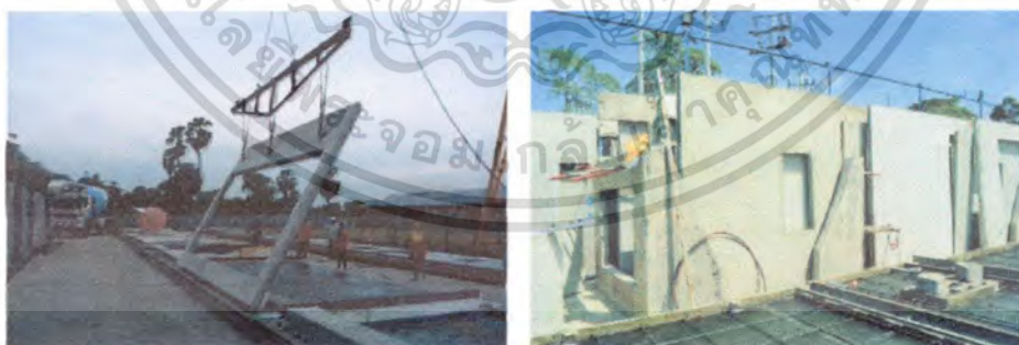
รูปที่ 4.82 แสดงการยกชิ้นส่วนออกจาก line การผลิต แล้วนำมากองเก็บใน rack
