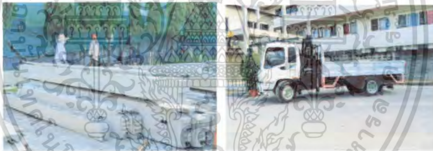
รูปที่ 5.3 แสดงระบบเสาคานสำเร็จรูป ของ บจก. ซีคอน ที่ส่งผลต่อเครื่องมือในการขนส่งและเครื่องมือในการติดตั้งชิ้นส่วน
