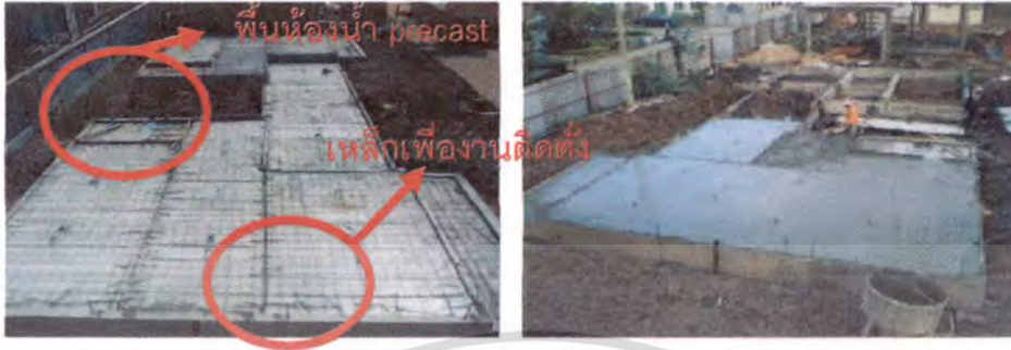
รูปที่ 4.86 แสดงงานเตรียมพื้นที่ก่อนการติดตั้งพื้นชั้นล่าง (ที่มา:เอกสารประกอบการเข้าเยี่ยมชมโรงงานการผลิต วันที่ 20 ตุลาคม 2553)
