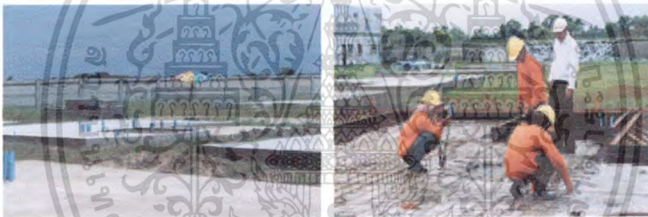
รูปที่ 4.131 แสดงขั้นตอนการเทพื้นชั้นล่าง
