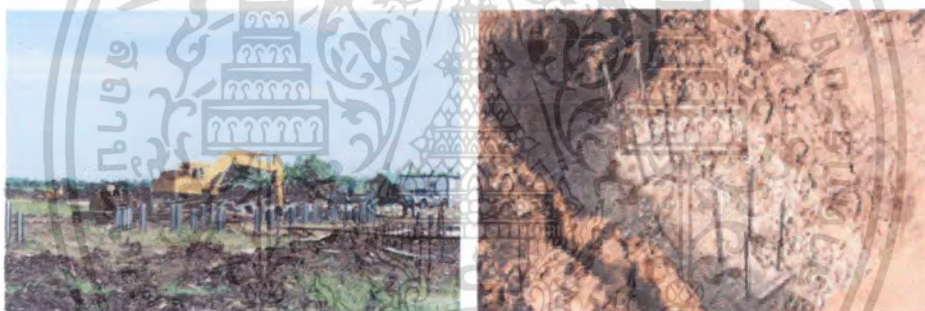
รูปที่ 4.128 แสดงการตอกเสาเข็ม (ที่มา:เอกสารประกอบการเข้าเยี่ยมชมโรงงานการผลิต วันที่ 17 ตุลาคม 2553)
