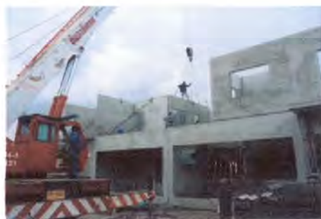
รูปที่ 4.77 แสดงตัวอย่างบ้านในระบบการก่อสร้างแบบผนังรับน้ำหนัก
