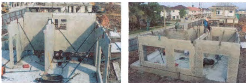
รูปที่ 4.88 แสดงการค้ำยันแผ่นด้วย prop up เหล็กขณะติดตั้งผนังชั้น 1 (ที่มา:เอกสารประกอบการเข้าเยี่ยมชมโรงงานการผลิต วันที่ 20 ตุลาคม 2553)
