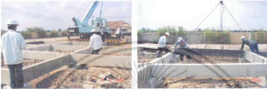
รูปที่ 4.52 แสดงการติดตั้งคานชั้นหนึ่ง
