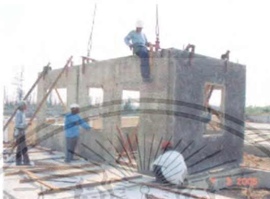
รูปที่ 4.56 แสดงการติดตั้งชิ้นส่วนผนัง
