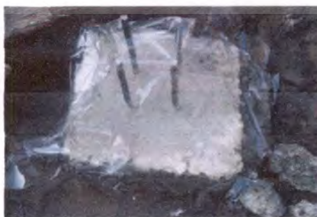
รูปที่ 4.16 แสดงขั้นตอนการหล่อฐานราก
