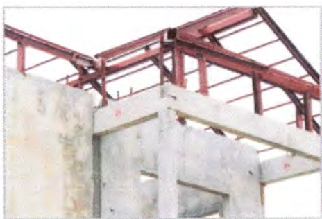
รูปที่ 4.64 แสดงการติดตั้งโครงสร้างงานหลังคา
