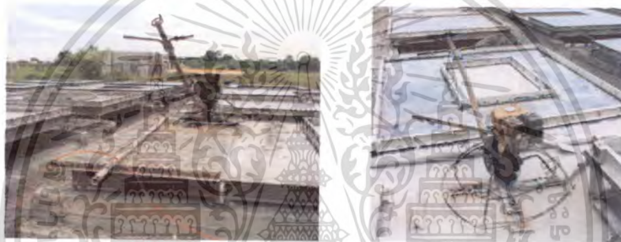
รูปที่ 5.12 แสดงเครื่องขัดผิวหน้าชั้นส่วนแบบใบพัดที่เรียกว่าแมลงปอ
