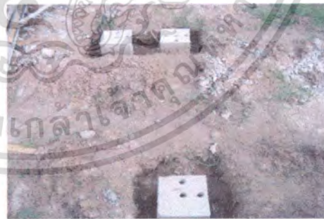
รูปที่ 4.51 แสดง FOOTING มีไว้สำหรับเสียบเหล็กเสริม ขนาด DB.12 มม.
