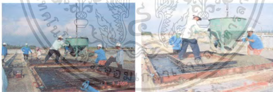
รูปที่ 4.47 แสดงการเทคอนกรีตลงแบบหล่อ
