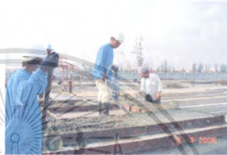
รูปที่ 4.48 แสดงการขัดผิวหน้าชั้นด้วยแรงงานคน (ที่มา:เอกสารประกอบการเข้าเยี่ยมชมโรงงานการผลิตชิ้นส่วนวันที่10 กันยายน 2553)
