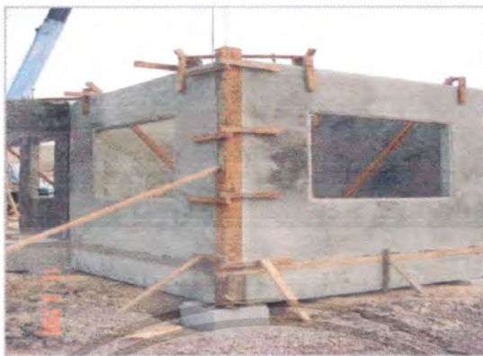
รูปที่ 4.60 แสดงการเข้าแบบไม้ก่อนการเทปูน
