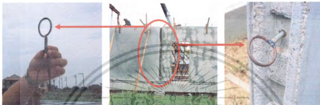
รูปที่ 4.58 แสดงห่วง ขนาด 9 มม. ใช้สำหรับยึดระหว่างช่วงผนังต่อผนัง ระยะห่าง 12 ซม.
