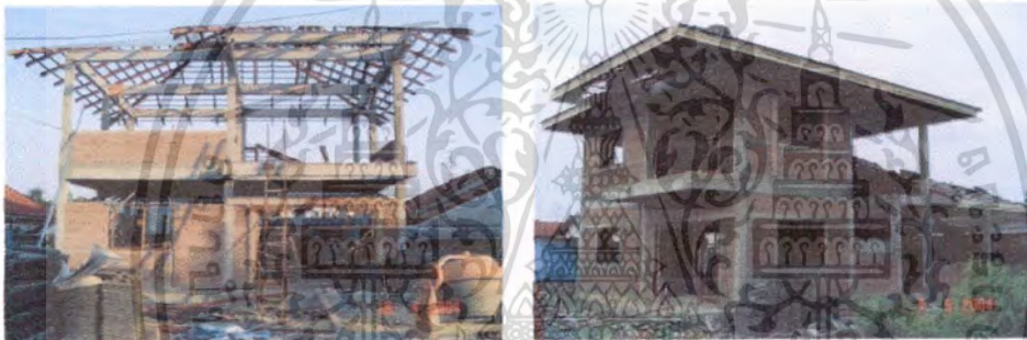
รูปที่ 4.21 แสดงขั้นตอนการก่อผนัง
