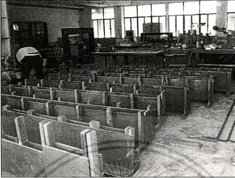
รูปที่ 4.12 แบบไม้หล่อคานคอนกรีต
