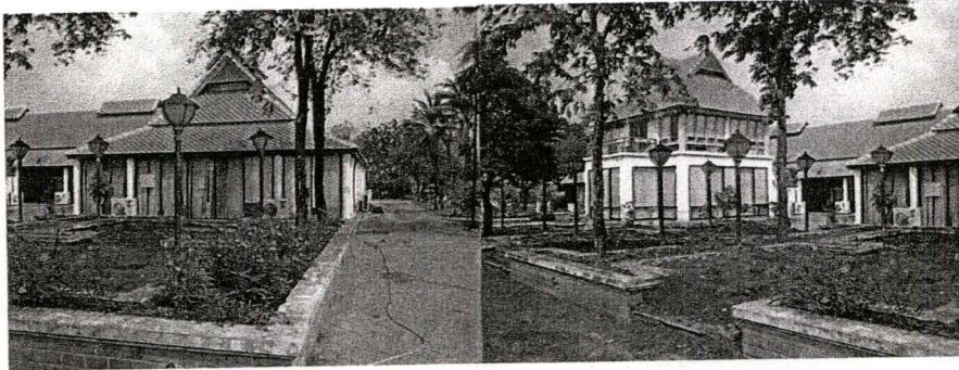
ภาพที่ 4.25 แสดงอาคารปีก ไชน C ที่ยังไม่ได้งบประมาณในการตกแต่ง
