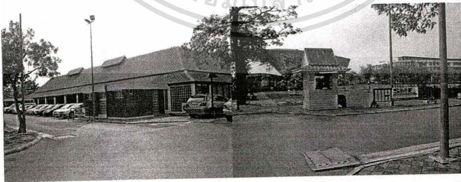
ภาพที่ 4.24 แสดงอาคารปีก ไชน B ที่ใช้งานในปัจจุบัน
