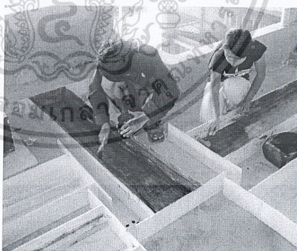
รูปที่ 3.8 แสดงแบบหล่อตัวอย่าง (ซ้าย) และการทำน้ำมันที่ผิวไม้แบบ (ขวา)
