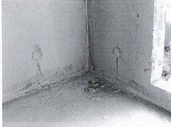
รูปที่ ข13. รูปแบบการติดตั้งจุดสวม Dowel Bar และการประกอบชิ้นส่วนในรอยต่อแบบ Bolt หรือ Dowel Bar ระหว่างพื้น Flat Slab กับผนังสำเร็จรูป
