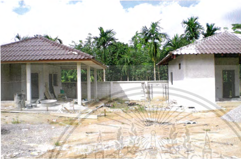
ภาพที่ 7 แสดงพื้นที่ระหว่างตัวบ้านหลังที่ 1 และ หลังที่ 2 ก่อนทำการปรับปรุง
