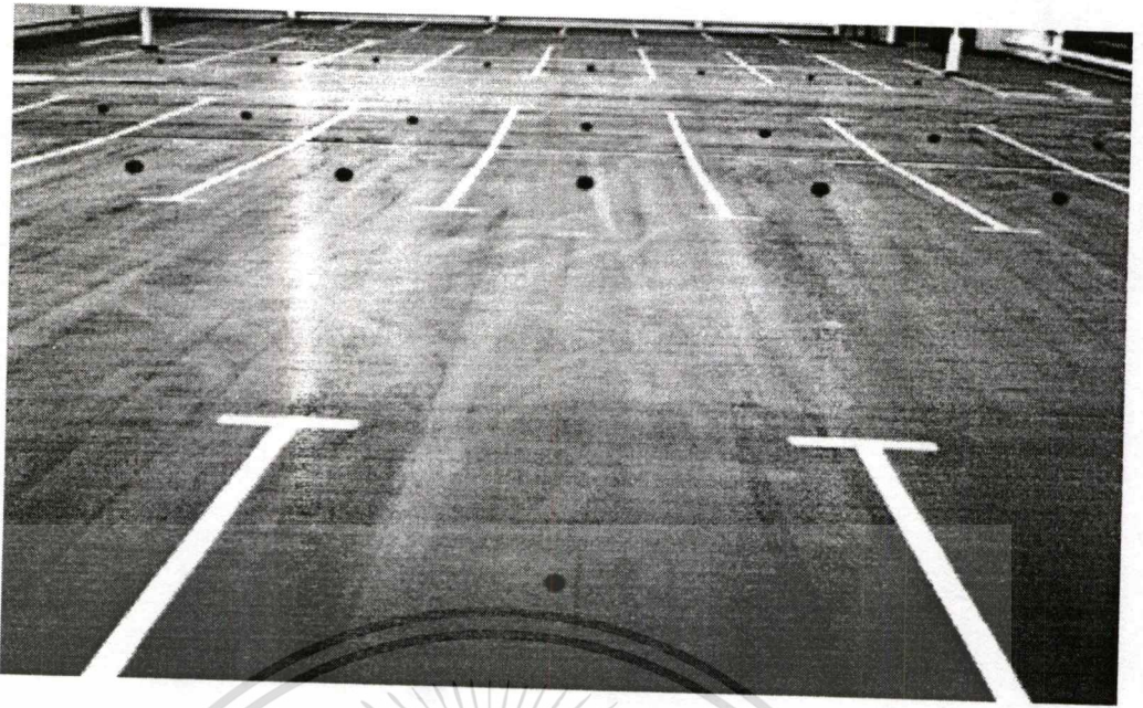
รูปที่ 3.12 แสดงตำแหน่งการวางเซนเซอร์เพื่อใช้ในการตรวจจับสถานะที่จอดรถ
