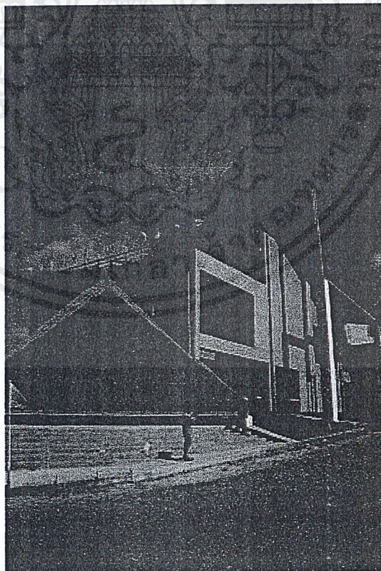
รูปที่ 30 รูปถ่ายลักษณะอาคารด้านตรวจคนเข้าเมืองช่องเม็ก
