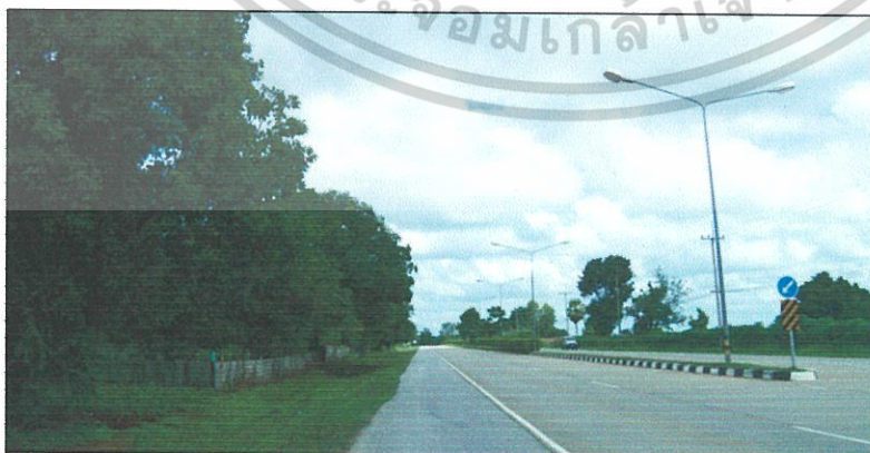
รูปที่ 5.19 ภาพถ่ายทาง u-turn ก่อนเข้าสู่โครงการ
