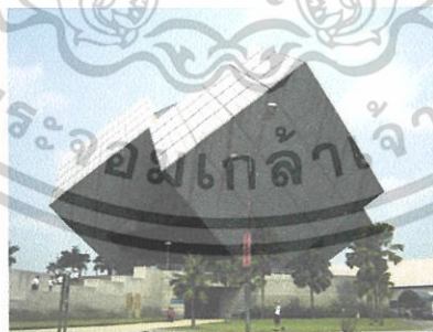
รูปที่ 3.61 ภาพแสดงคราบน้ำมันจากเครื่องบินทำปฏิกิริยากับผนังเซรามิกและน้ำฝนทำให้เกิดคราบ
