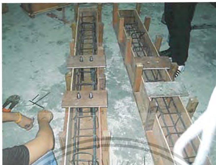
รูปที่ 4.7 แสดงการต่อเหล็กเกลียวเข้ากับแบบเพื่อหล่อเสาคอนกรีตเสริมเหล็ก
