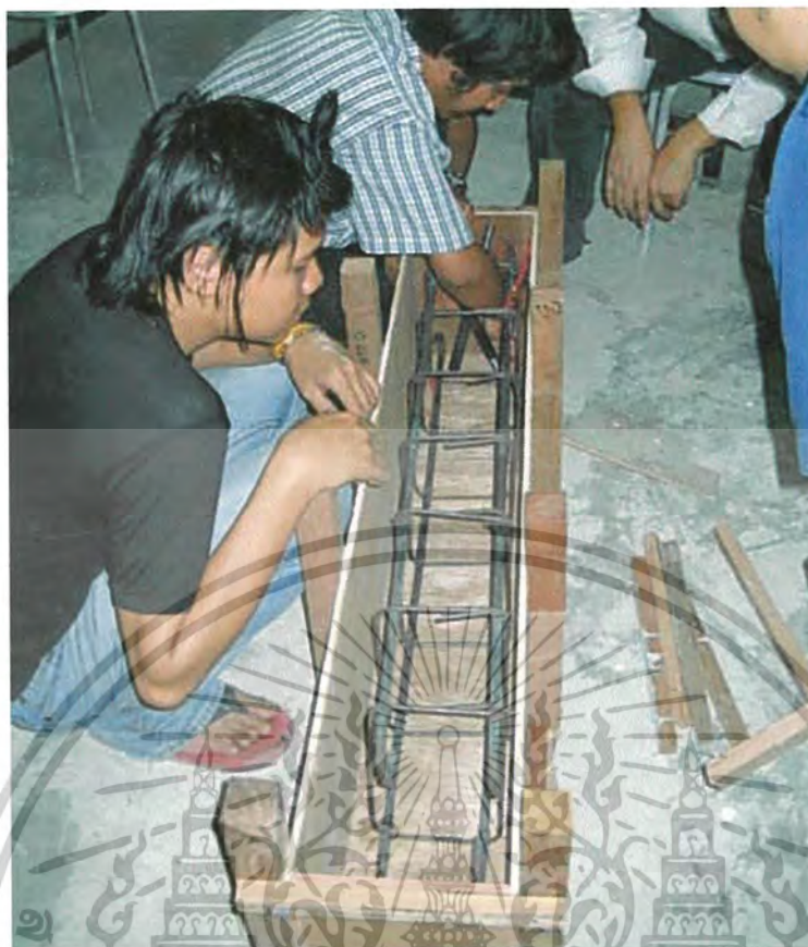
รูปที่ 4.9 แสดงการต่อเหล็กเกลียวเข้ากับแบบเพื่อหล่อคานคอนกรีตเสริมเหล็ก
