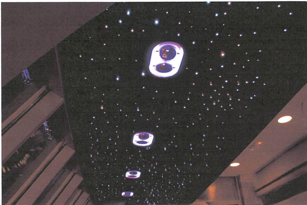
ภาพที่ 19 เส้นใยนำแสงมีปลอกหุ้มแบบแสงออกปลาย (Single-core End light optical Cable)
