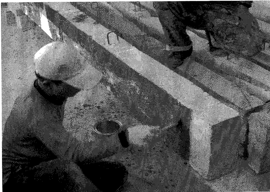
รูปที่ 4.9 แสดงการทำวัสดุประสานชั้นที่สอง
