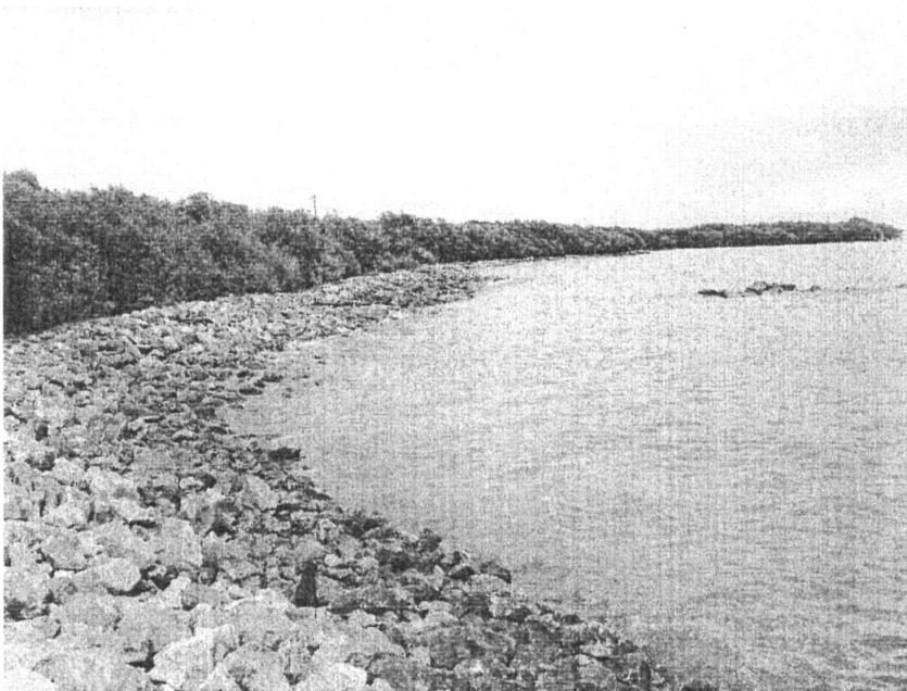
ภาพที่ 5 แนวสลายพลังงานคลื่นแบบแนวหินทิ้ง
