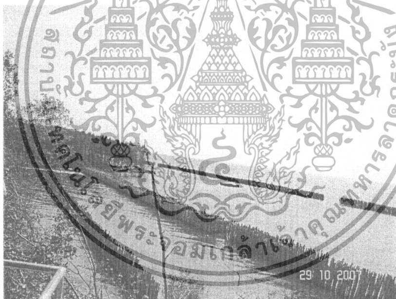
ภาพที่ 3 แนวสลายพลังงานคลื่นแบบแนวไม้ไผ่
