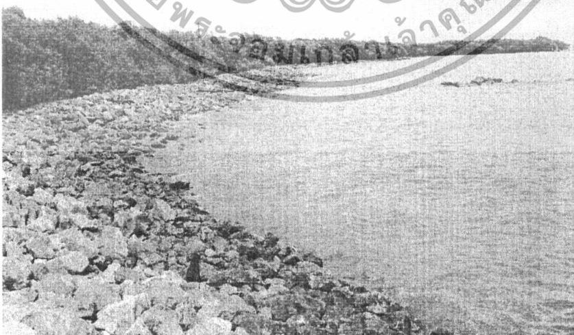
ภาพที่ 5 แนวสลายพลังงานคลื่นแบบแนวหินทิ้ง
