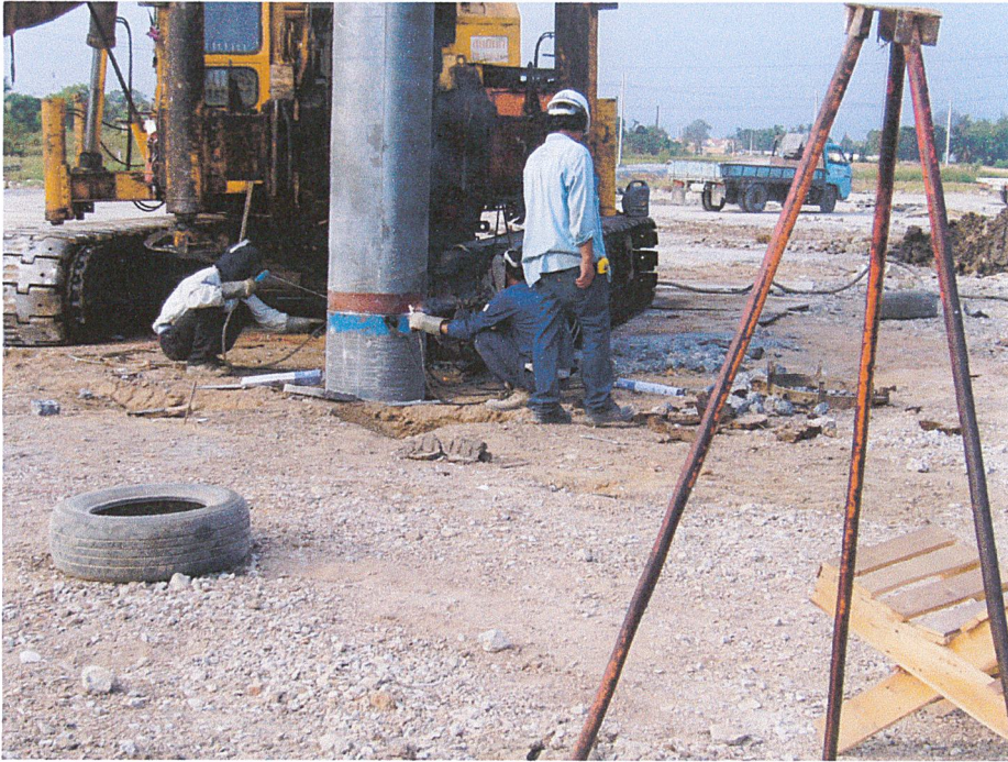
รูปที่ 4.15 แสดงการต่อเสาเข็มโดยวิธีการเชื่อม
