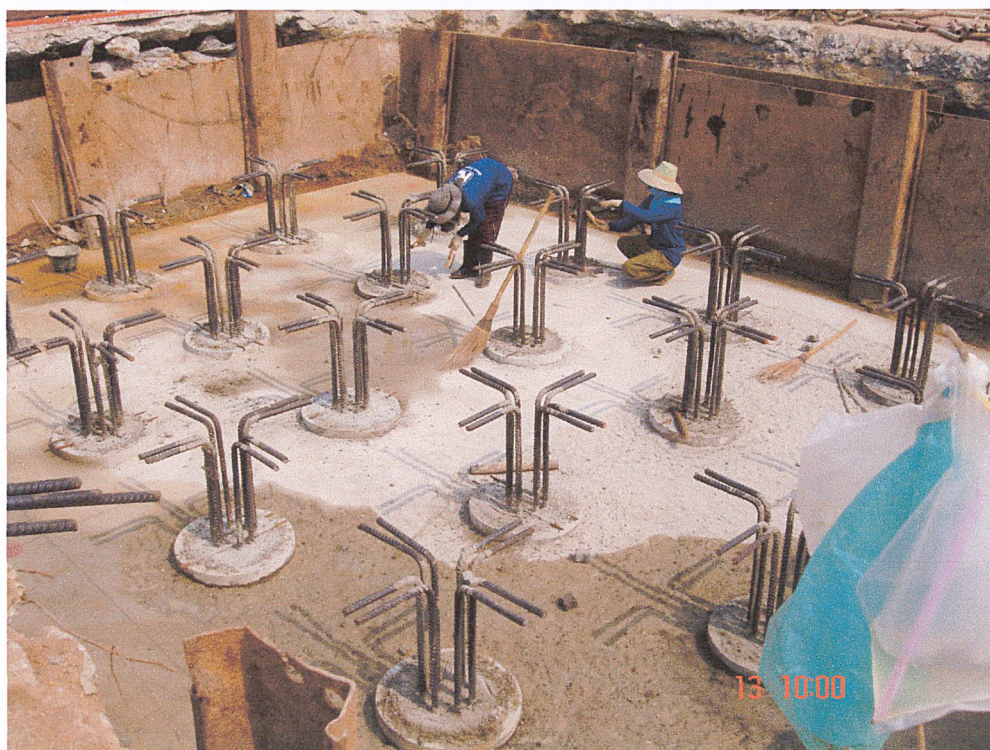
รูปที่ ก-8 คนงานกำลังใส่เหล็ก Dowel Bar
