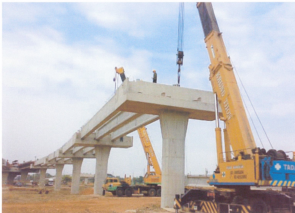
รูปที่ 7.13 แสดงการยกชิ้นส่วน I-Girder มาวางลงบน Crossbeam
