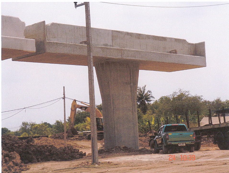
รูปที่ ก-17 Crossbeam
