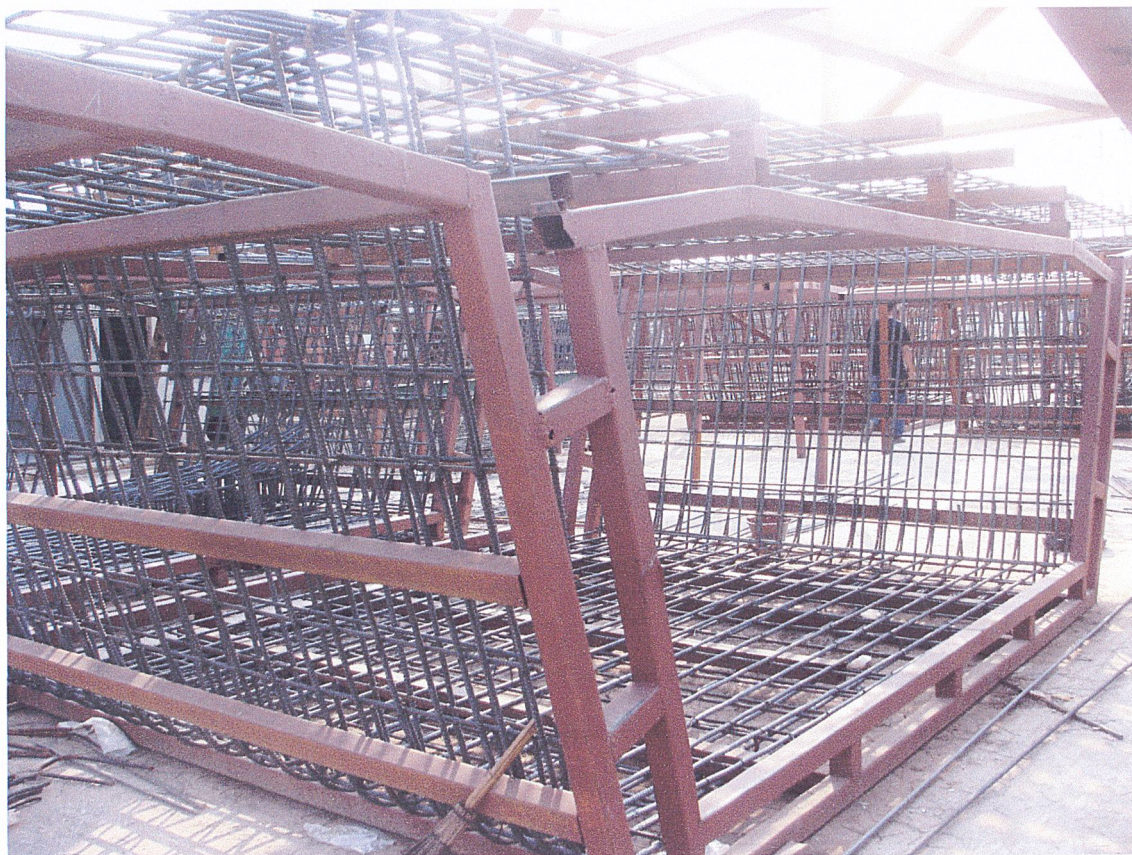
รูปที่ 9.3 ก แสดง การผูกเหล็กของ Segments Box Girder
