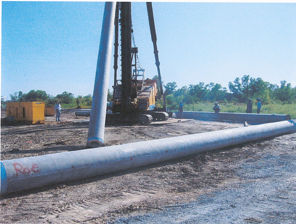
รูปที่ ก-4 รถตอกเสาเข็มกำลังยกเสาเข็ม
