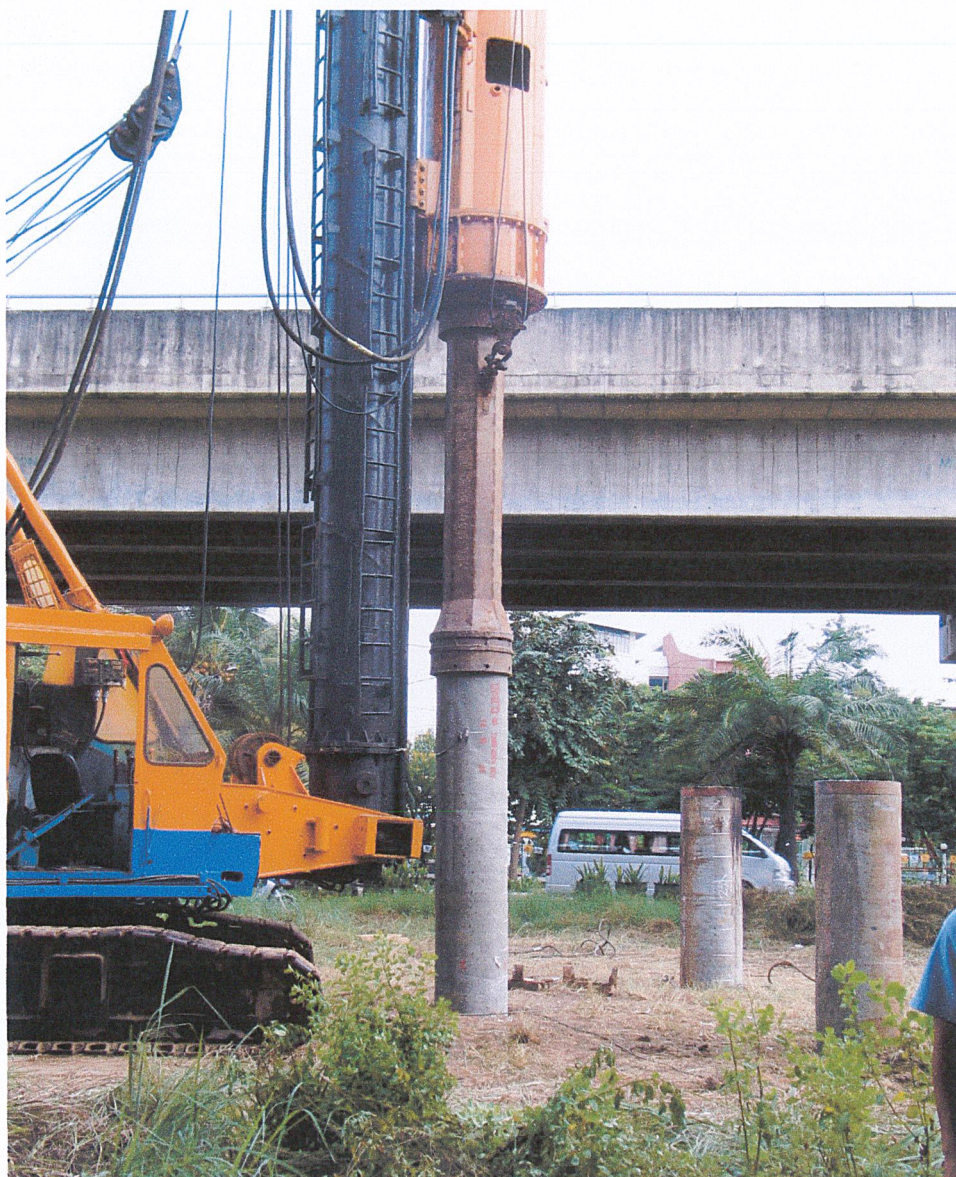
รูปที่ 4.14 แสดงการทำงานของเครื่องตอกระบบ Hydraulic Hammer
