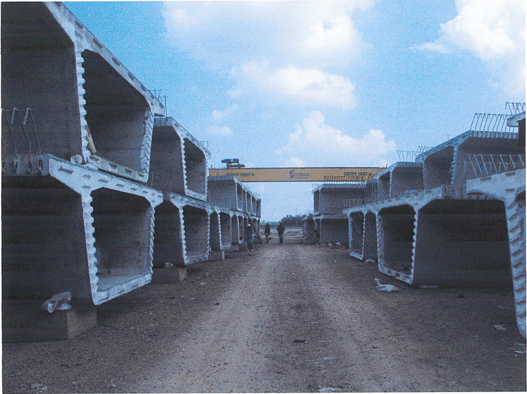
รูปที่ 9.6 แสดงการกองเก็บของชิ้นส่วน Segments Box Girder เพื่อรอนำไปใช้งาน
