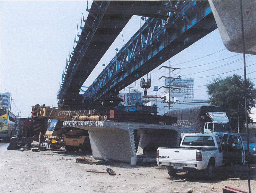
รูปที่ 9.9 แสดงการยก Segment Box Girder
