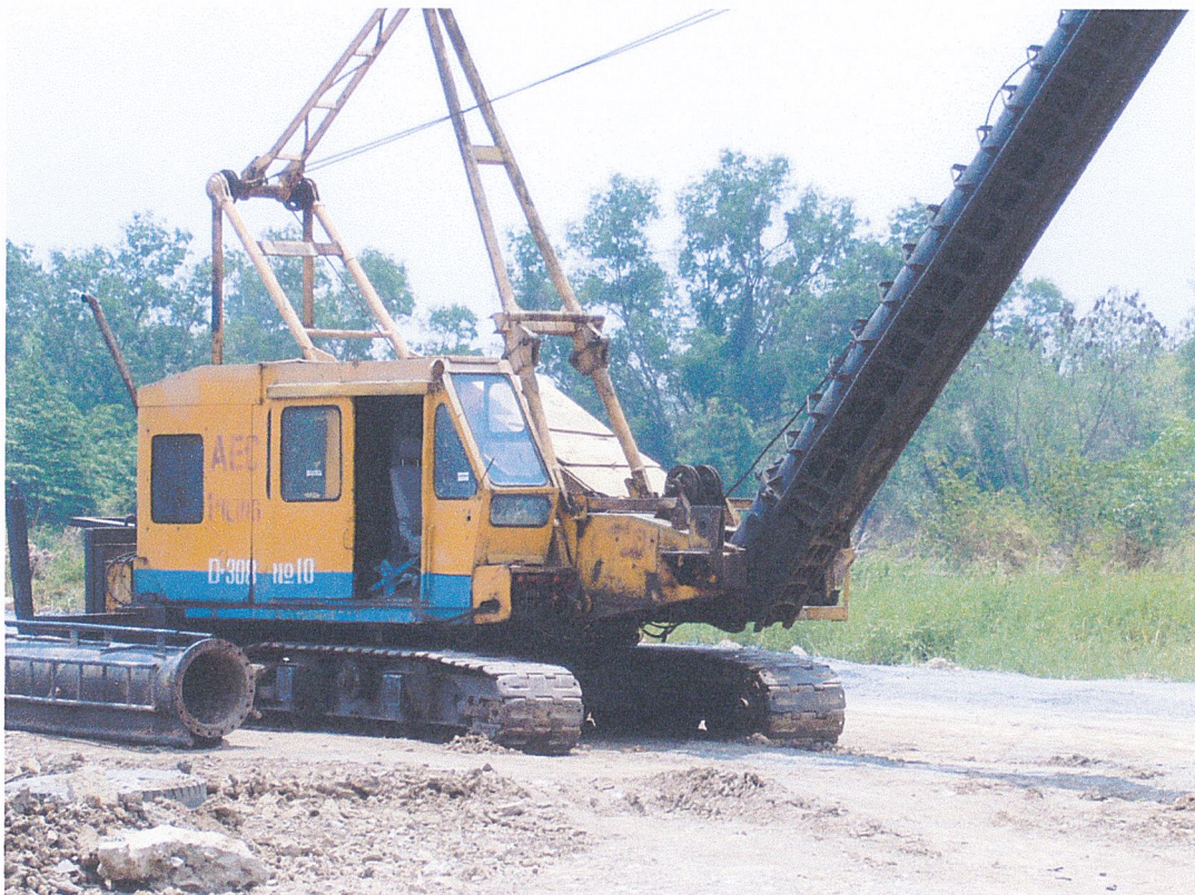
รูปที่ 4.10 แสดงรถตอกโดยใช้ Hydraulic Hammer
