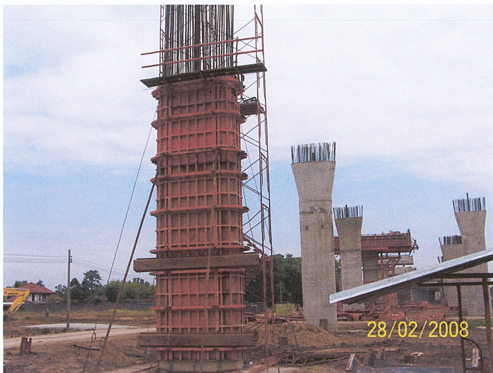
รูปที่ ก-14.2 เข้าแบบ Column
