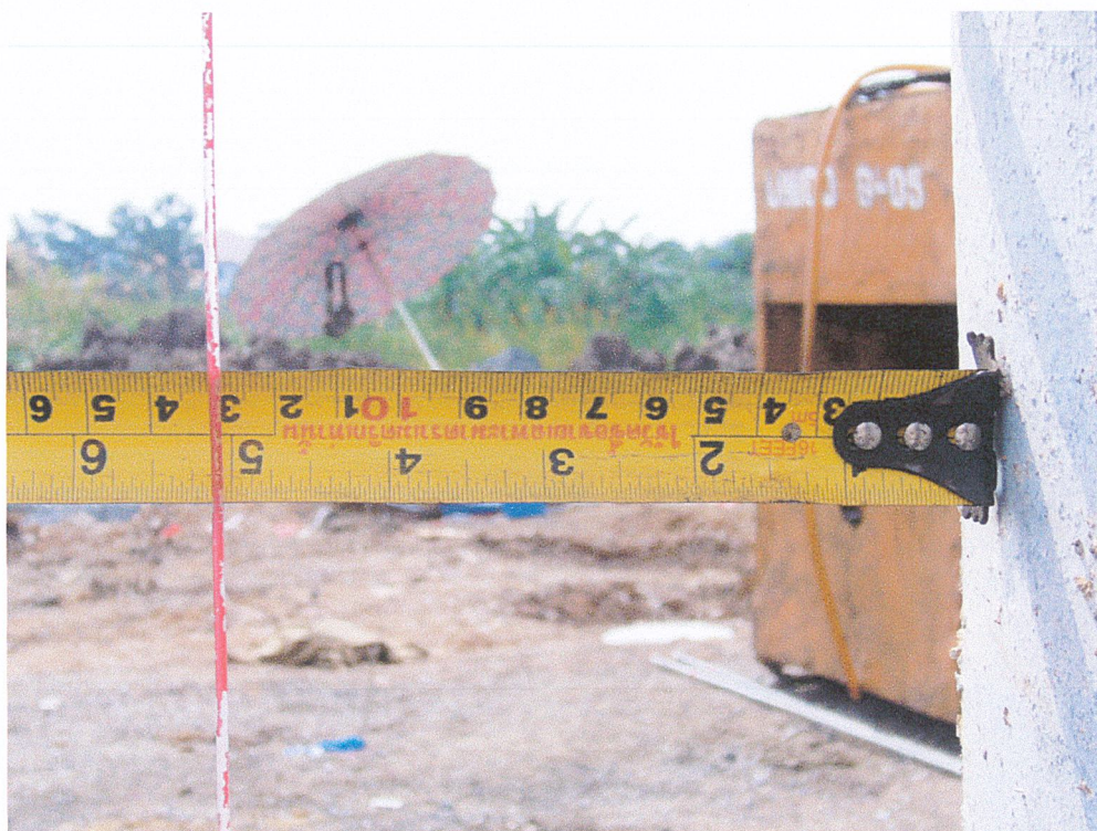
รูปที่ ก-5 การเช็ดคดิ่งเสาเข็ม
