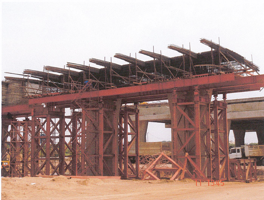
รูปที่ 5.10 ก แสดง การติดตั้งนั่งร้านเพื่อรองรับแบบหล่อคานขวาง
