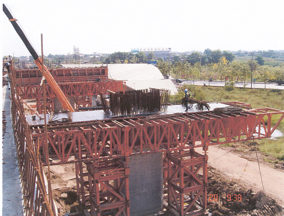
รูปที่ 5.10 ข แสดง การติดตั้งนั่งร้านพื้นเพื่อรองรับแบบหล่อคานขวาง
