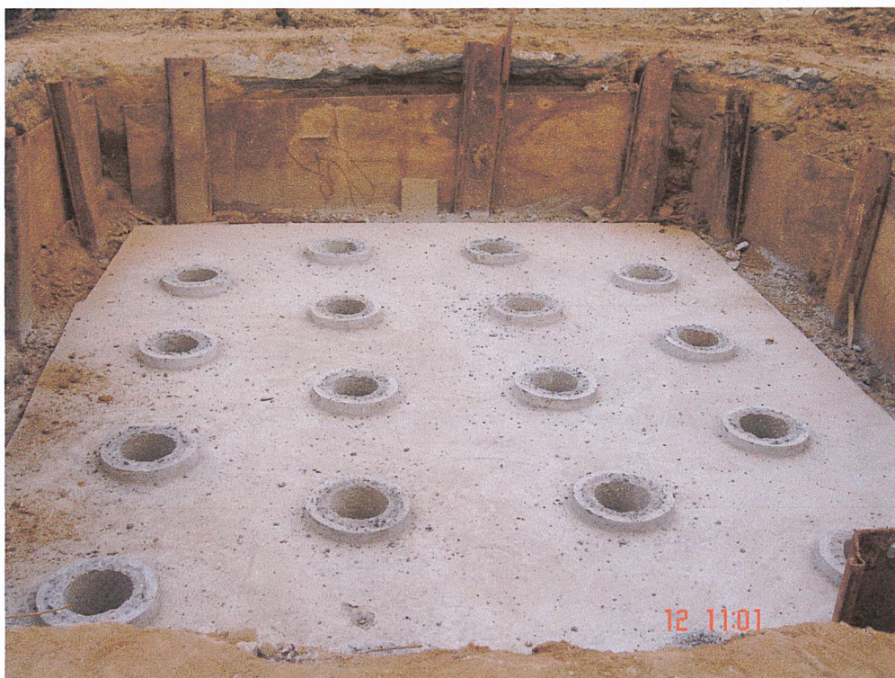
รูปที่ ก-7 กลุ่มของเสาเข็มที่ตอกเสร็จแล้ว
