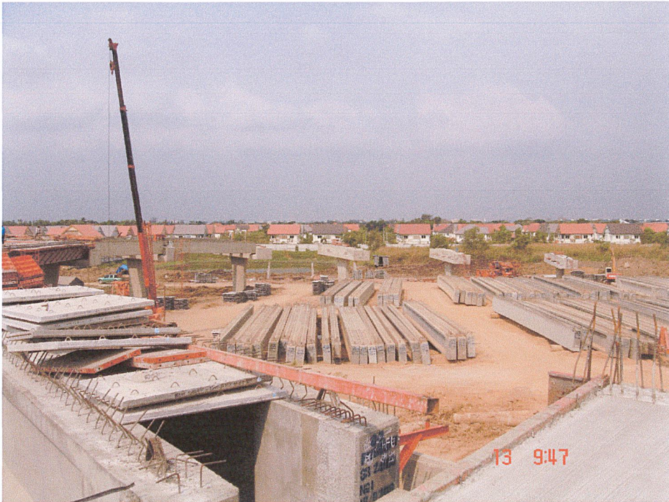
รูปที่ ก-20 การจัดเก็บชิ้นส่วน I-Girdersรอทำการยกไปติดตั้ง
