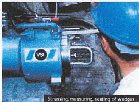
รูปที่ 7.5 แสดงการดึงลวดเหล็กอัดแรง
