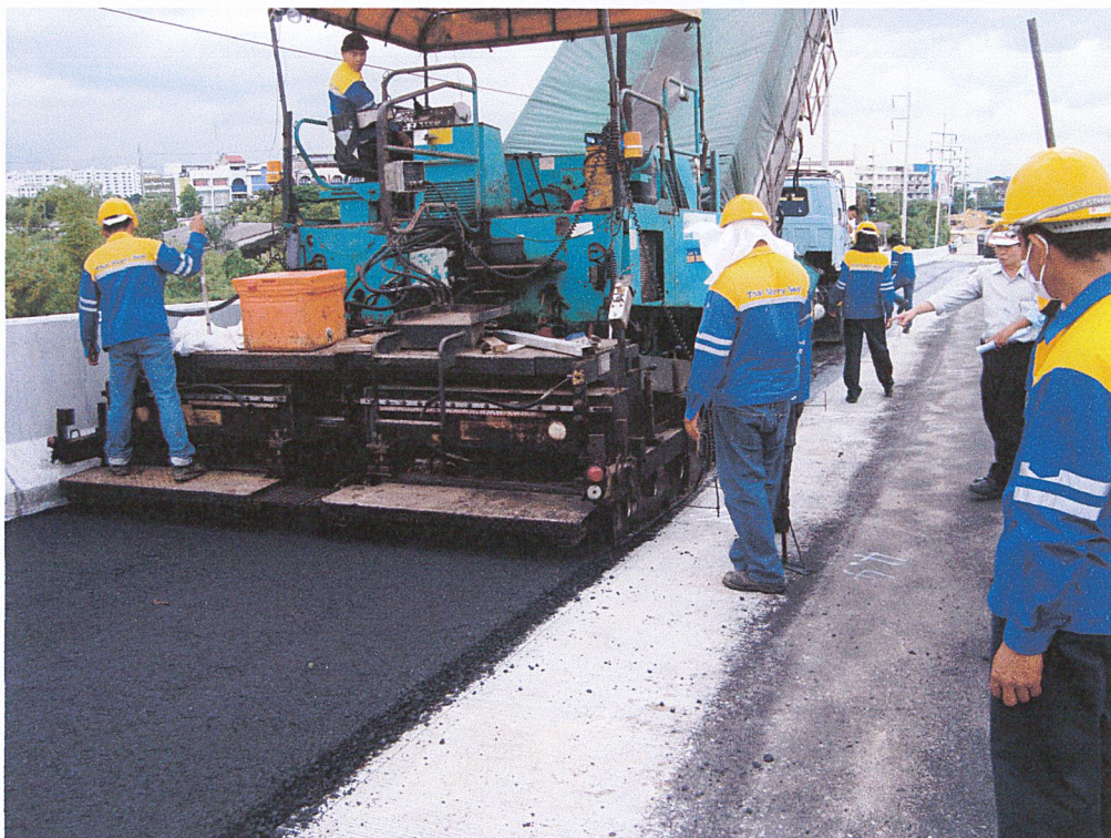
รูปที่ 7.16 แสดงการทำผิวทางลาดยางคอนกรีต
