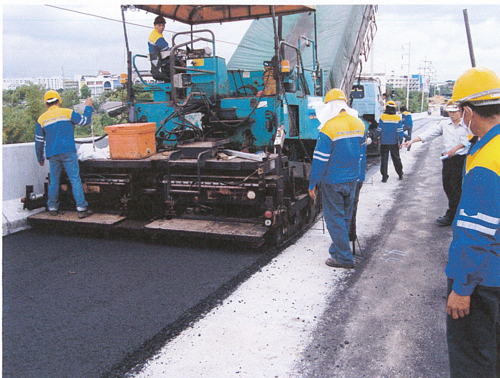
รูปที่ ก-23 เท Asphalt Concrete
