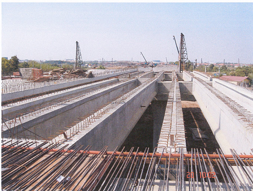
รูปที่ 7.14 แสดงส่วนที่ต้องหล่อชิ้นส่วน I-Girder กับชิ้นส่วน Crossbeam
