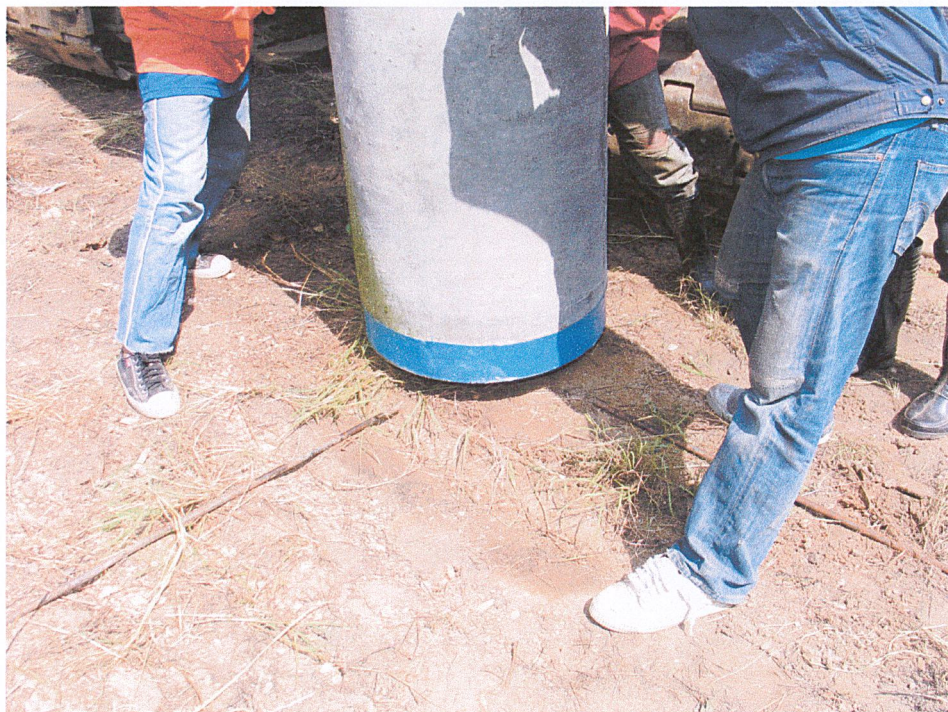
รูปที่ 4.12 แสดงการใช้กำลังคนในการปรับเสาเข็มให้ได้ตามจุดที่ต้องการตอก
