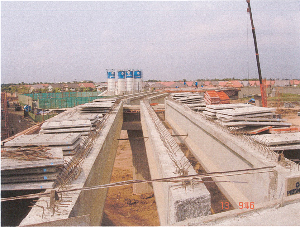
รูปที่ ก-21.2 ชิ้นส่วน I-Girder ที่วางเสร็จเรียบร้อยแล้ว
