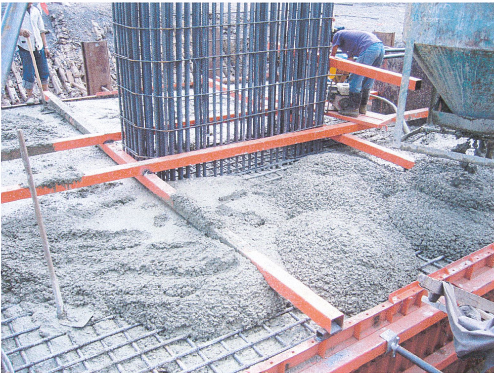
รูปที่ ก-10 เทคอนกรีต Footing
