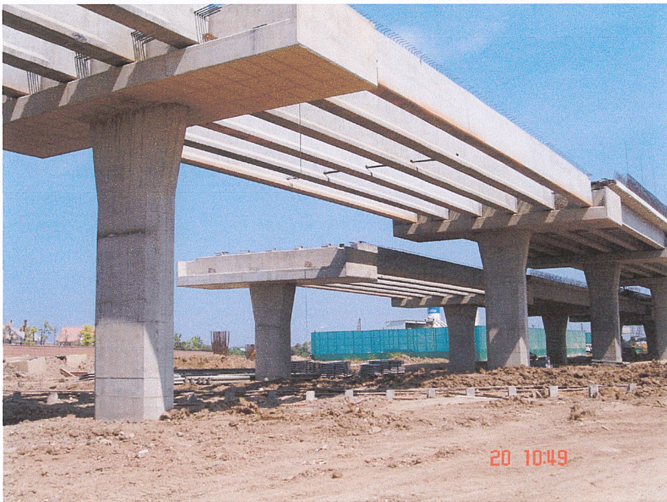
รูปที่ ก-21.1 ชิ้นส่วน I-Girder ที่วางเสร็จเรียบร้อยแล้ว
