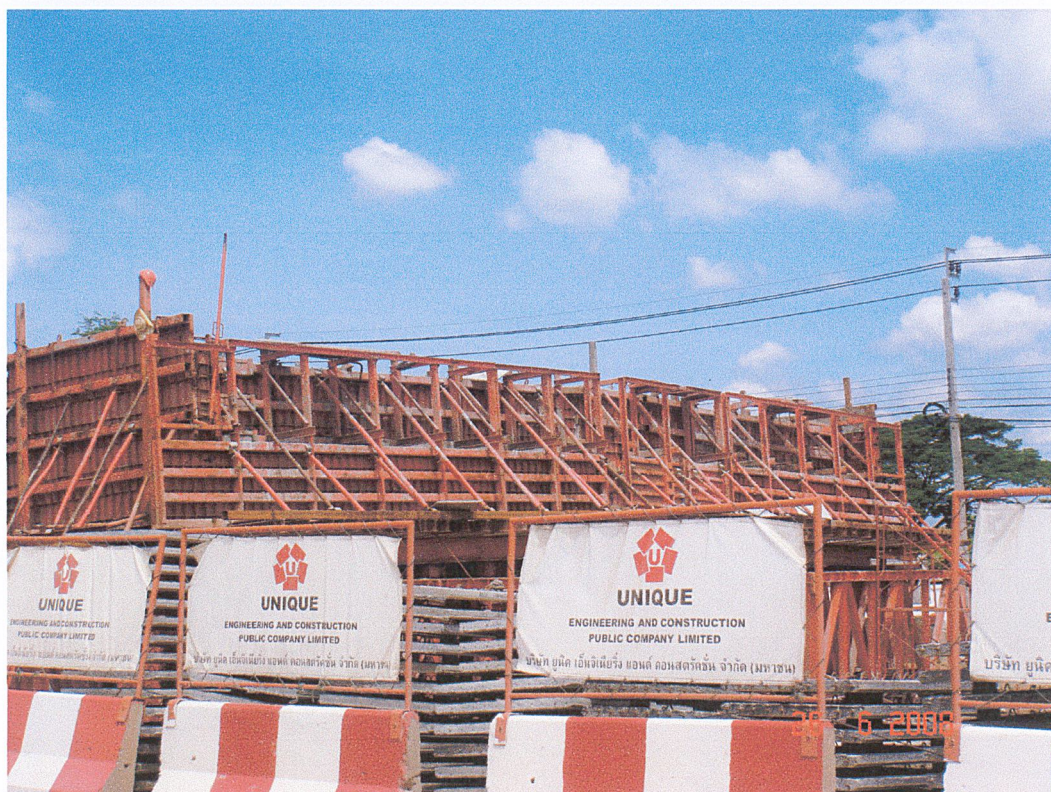
รูปที่ ก-24 แสดงรั้วป้องกันความปลอดภัย
