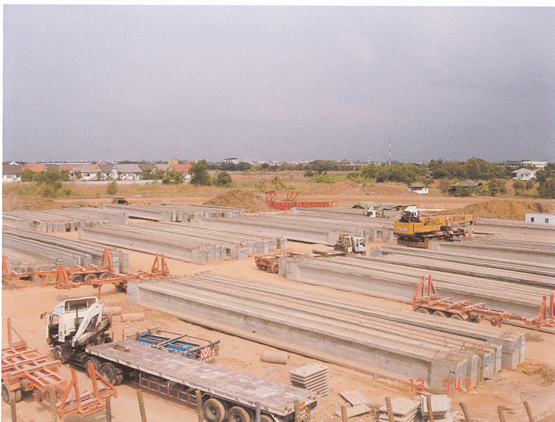
รูปที่ 7.9 แสดงการขนย้ายชิ้นส่วน I-Girder จากโรงผลิตชิ้นส่วนมายังสถานที่ก่อสร้าง
