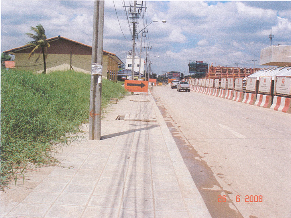
รูปที่ ก-25 แสดงป้ายทางเบี่ยงเมื่อมีการก่อสร้างบริเวณถนน
