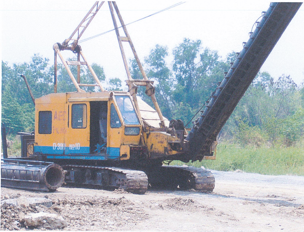
รูปที่ ก-3 รถตอกเสาเข็มโดยใช้ Hydraulic Hammer
