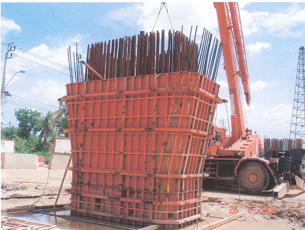
รูปที่ ก-14.1 เข้าแบบ Column
