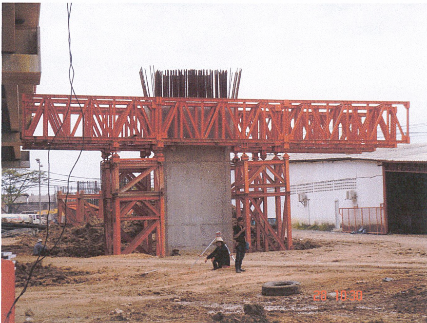
รูปที่ 5.9 ข แสดงการติดตั้ง Main Truss เตรียมหล่อ Cross Beam
