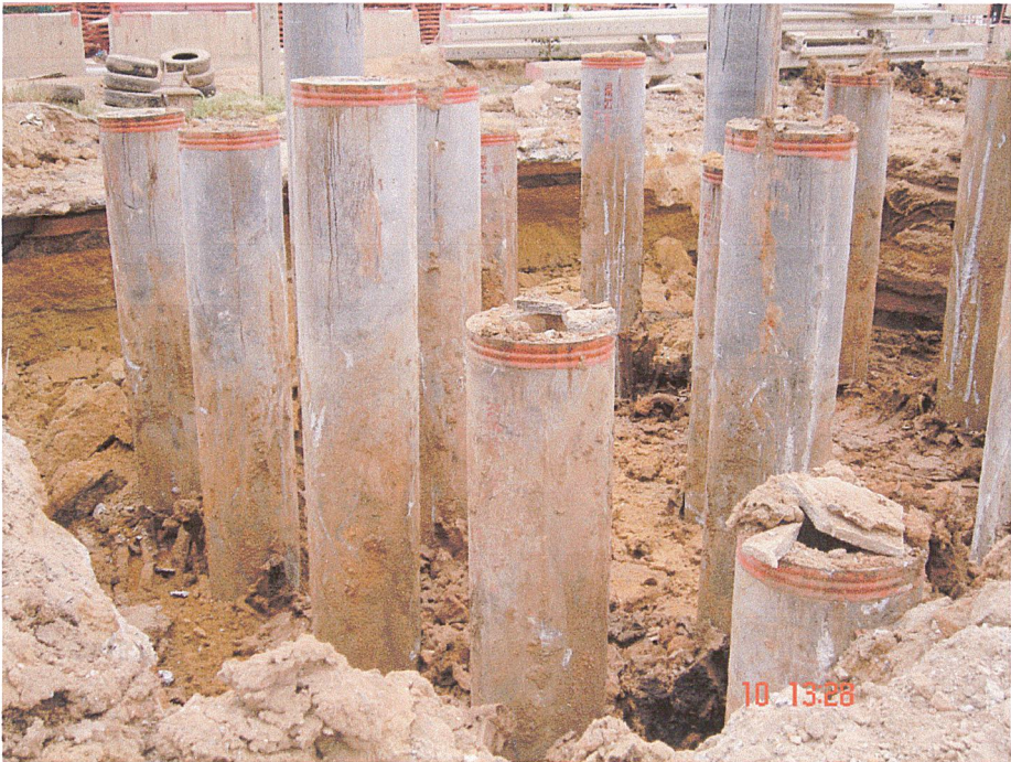
รูปที่ 4.16 แสดงเสาเข็มเมื่อทำการตอกเสร็จแล้ว
