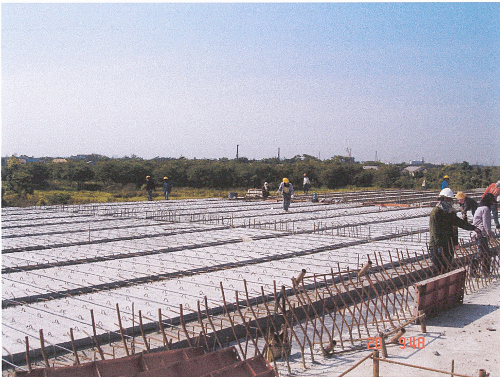
รูปที่ ก-22 วางแผ่นพื้นสำเร็จ
