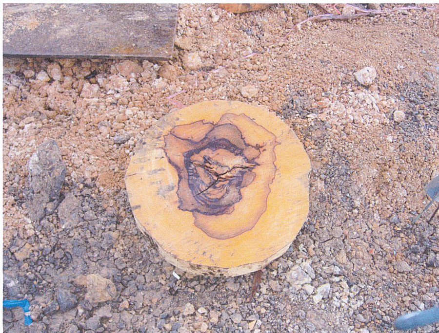
รูปที่ 4.13 แสดงไม้ที่ใช้รองหัวเสาเข็ม
