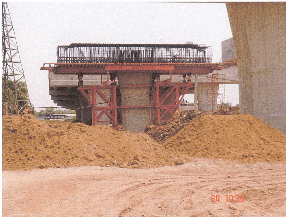
รูปที่ ก-15 นั่งร้านรับ Crossbeam
