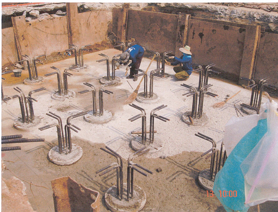
รูปที่ 4.19 แสดงการใส่เหล็ก Dowel Bar
