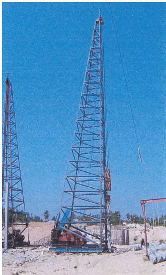
รูปที่ 4.5 แสดงลักษณะลูกตุ้มตอกเสาเข็มแบบ Drop Hammer
