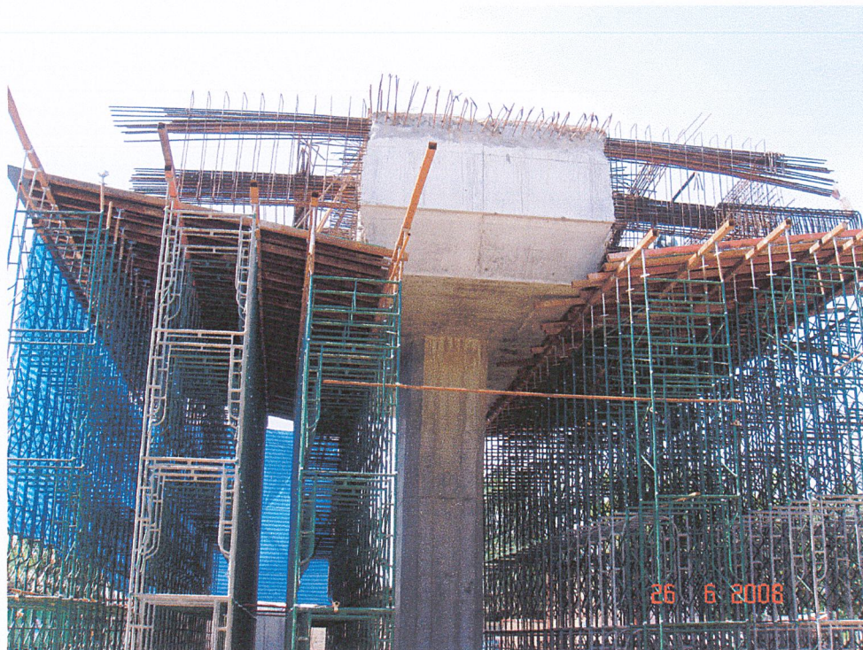
รูปที่ ก-18 นั่งร้านรองรับ Cantiliver desk
