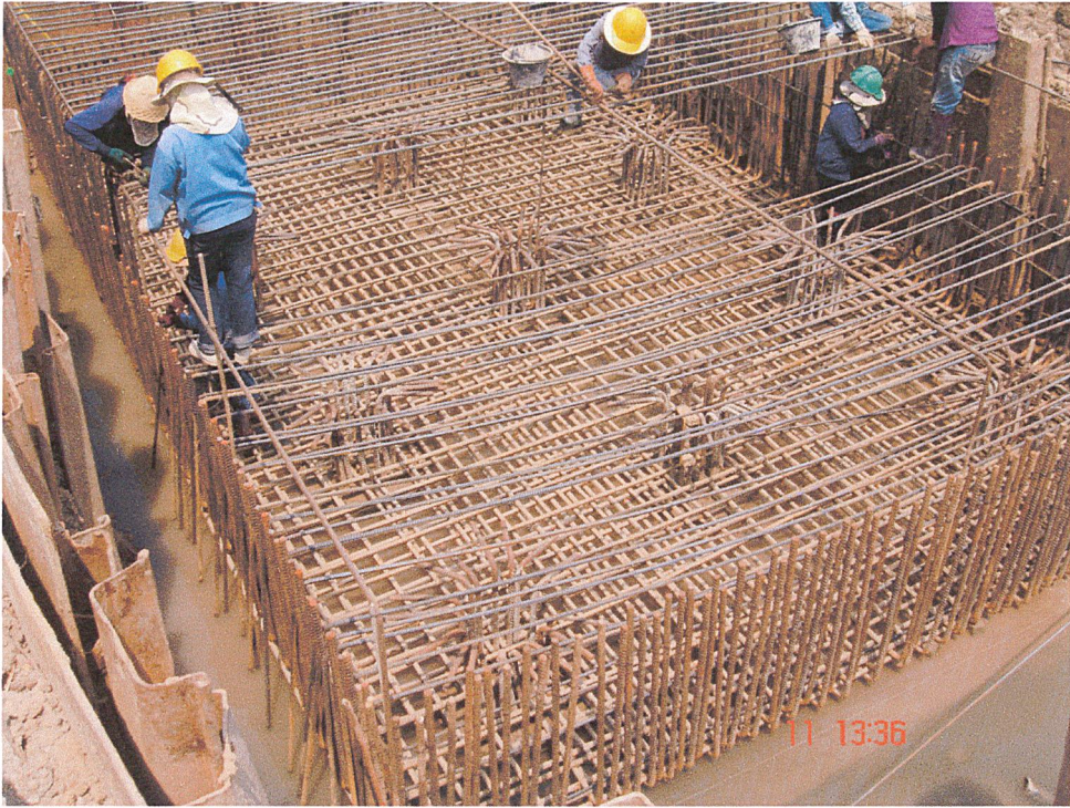
รูปที่ ก-9 คนงานกำลังผูกเหล็ก Footing
