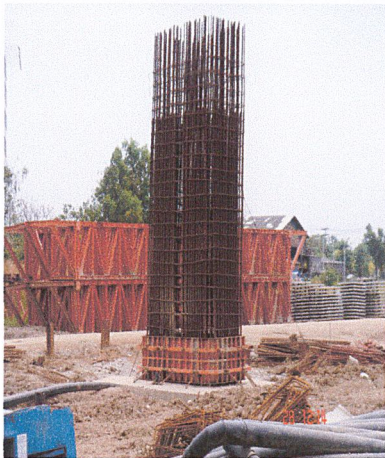
รูปที่ 5.1 แสดง แบบหล่อ Kicker Column
