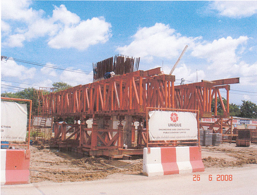
รูปที่ 5.9 ก แสดงการติดตั้ง Main Truss เตรียมหล่อ Cross Beam
