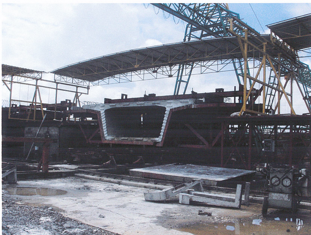
รูปที่ 9.5 แสดง Segments Box Girder ที่แข็งตัวแล้วตอนอยู่ใน Mould
