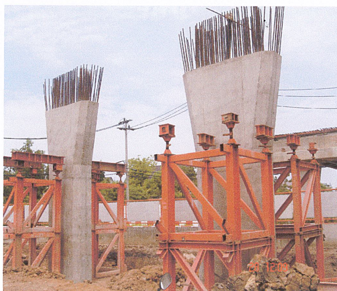
รูปที่ 5.8 แสดงการติดตั้งนั่งร้านของคานขวาง
