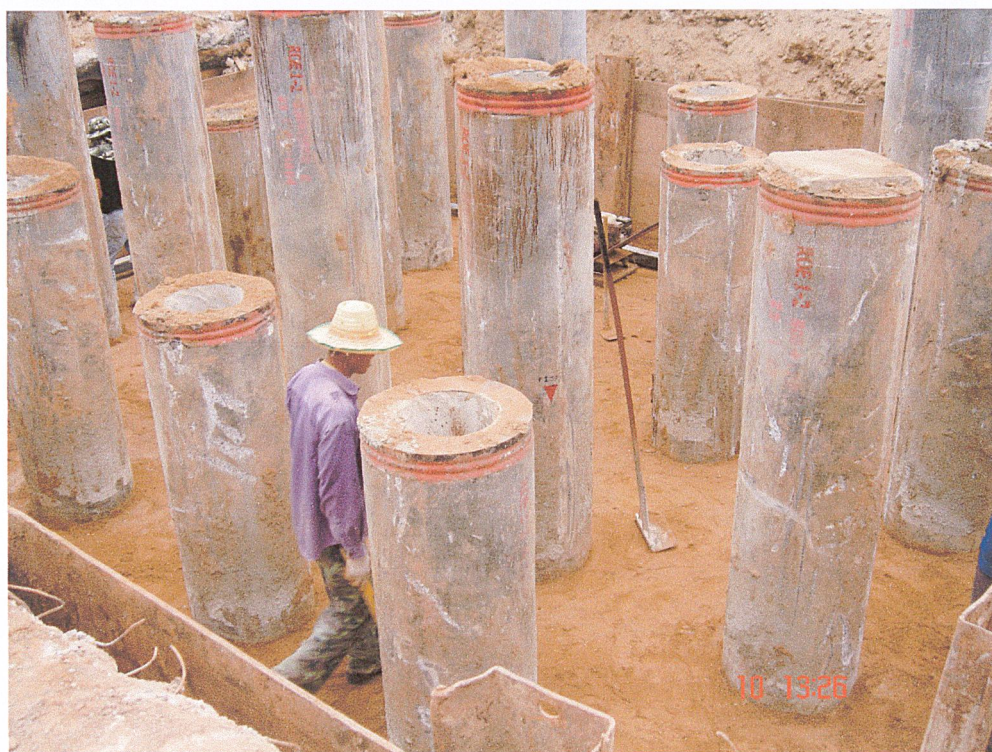
รูปที่ ก-6 กลุ่มของเสาเข็มที่ตอกเสร็จแล้ว
