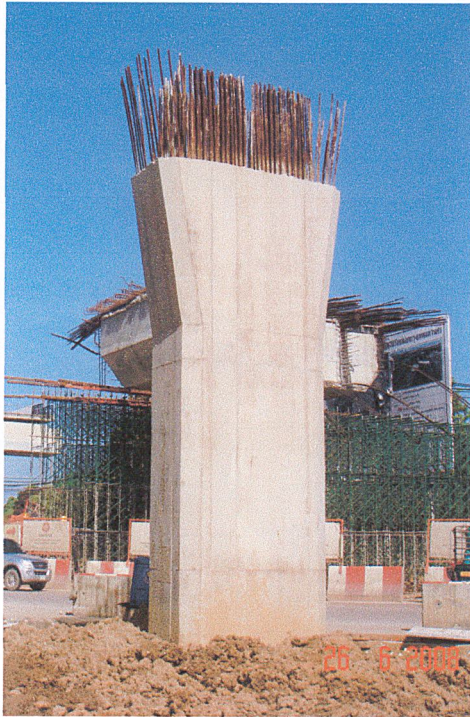
รูปที่ 5.4 แสดงการเทคอนกรีตและการบ่มคอนกรีต
