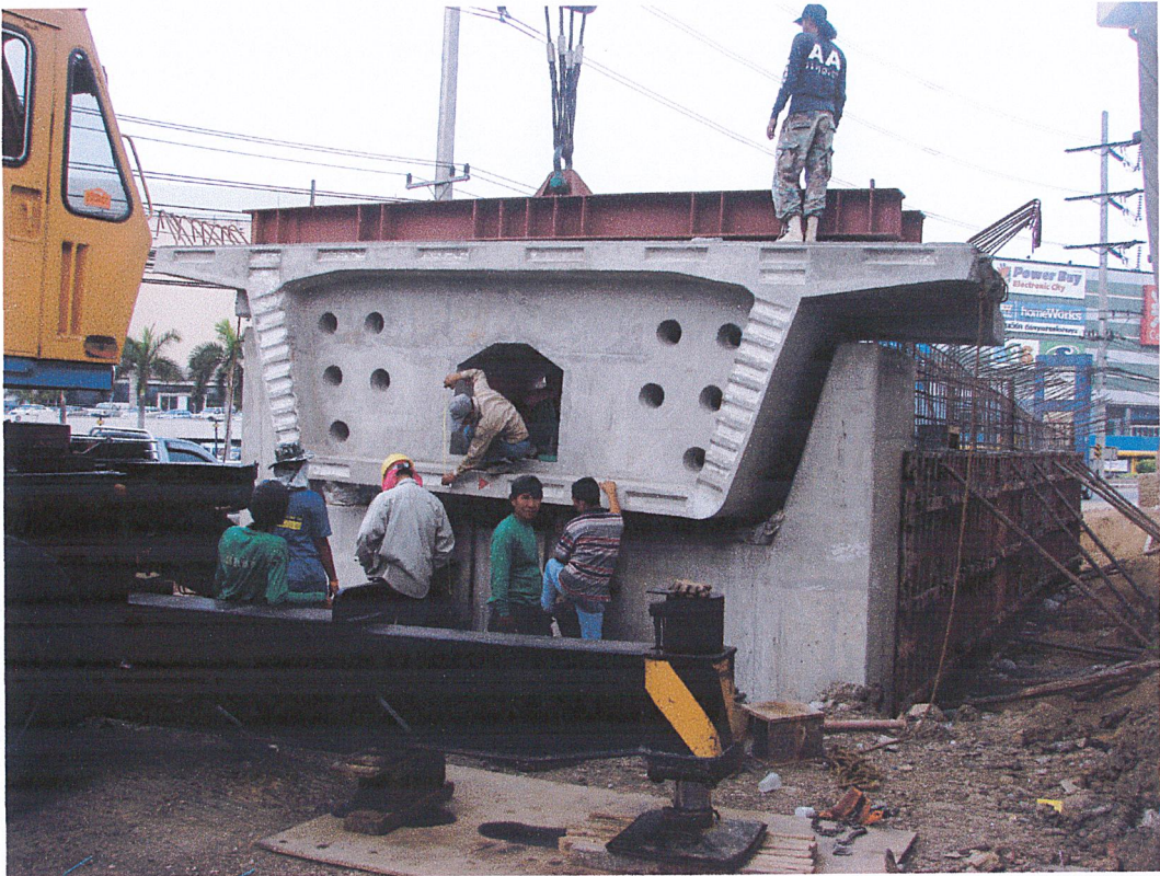
รูปที่ 9.7 แสดง การติดตั้ง Pier Segment
