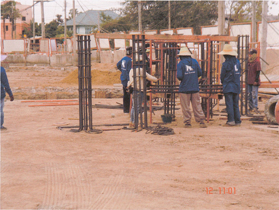
รูปที่ 4.17 แสดงการทำเหล็ก Dowel Bar
