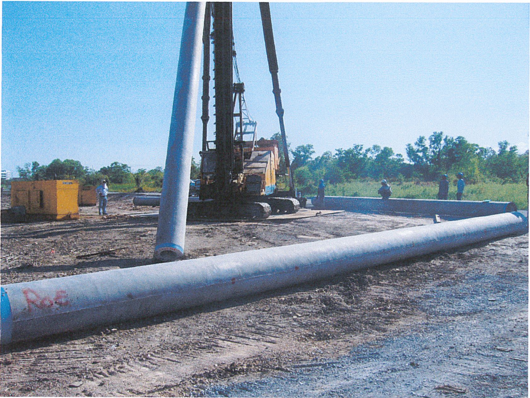
รูปที่ 4.11 แสดงการยกเสาเข็มขึ้นตั้ง
