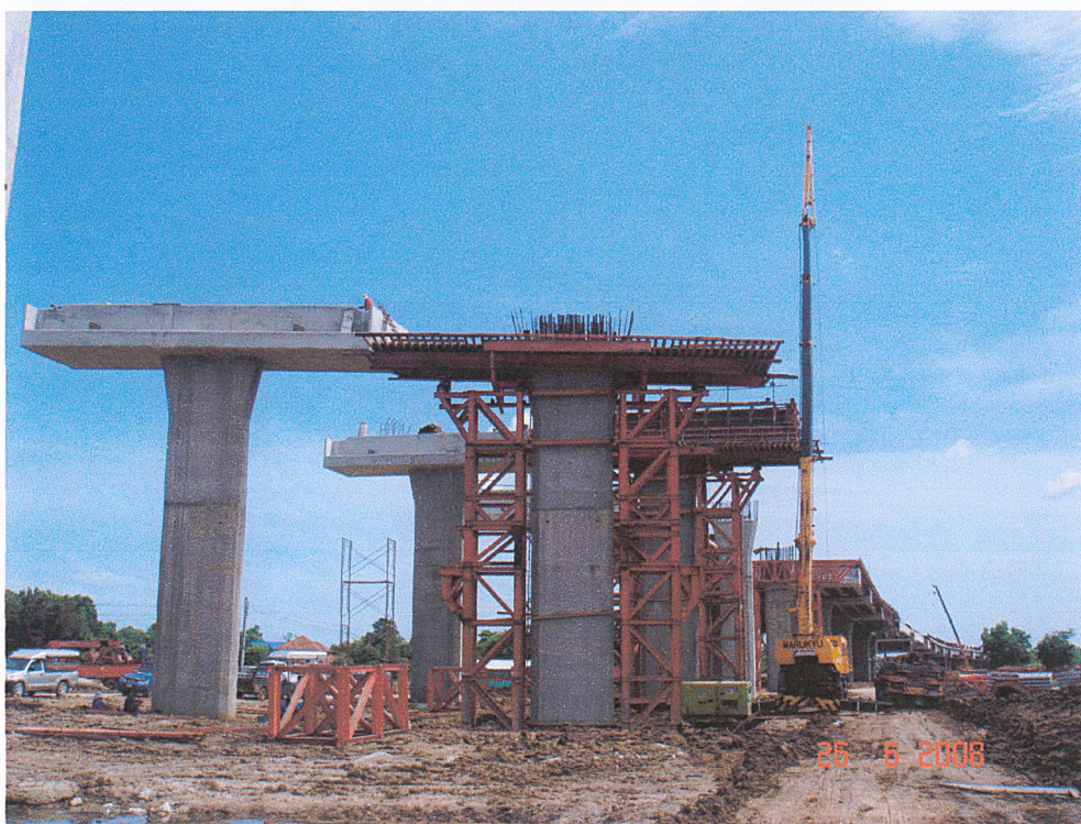
รูปที่ ก-19 เครนยกเหล็กขึ้นไปวางเพื่อทำ Crossbeam
