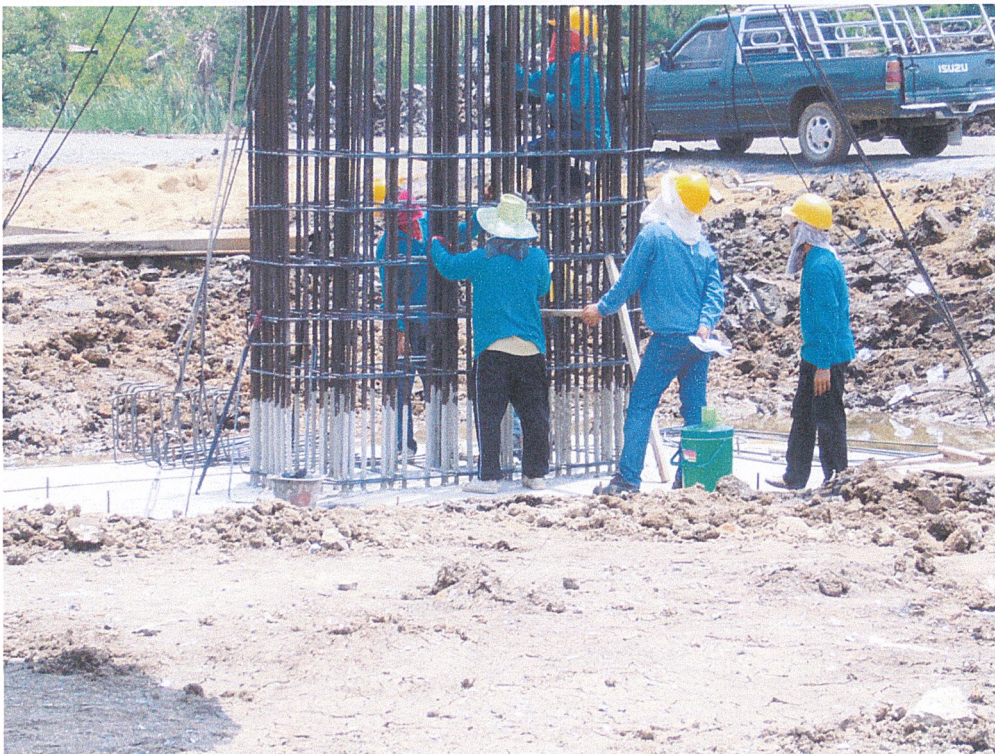
รูปที่ ก-12 คนงานกำลังผูกเหล็ก Column
