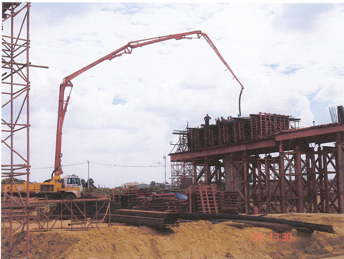
รูปที่ 5.11 แสดงการเทคอนกรีตโดยใช้เครื่องปั๊มคอนกรีตจากข้างล่างขึ้นข้างบน
