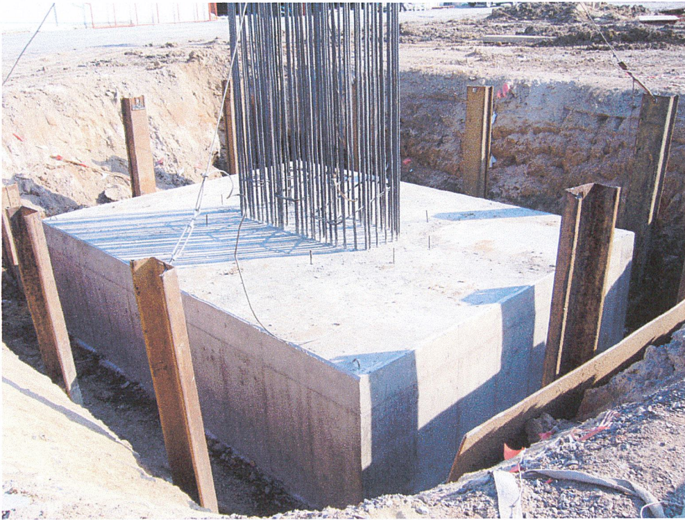
รูปที่ ก-11 Footingหลังการแกะแบบ
