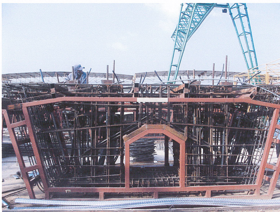
รูปที่ 9.4 แสดงการผูกเหล็กชิ้นส่วน Pier Segment Box Girder
