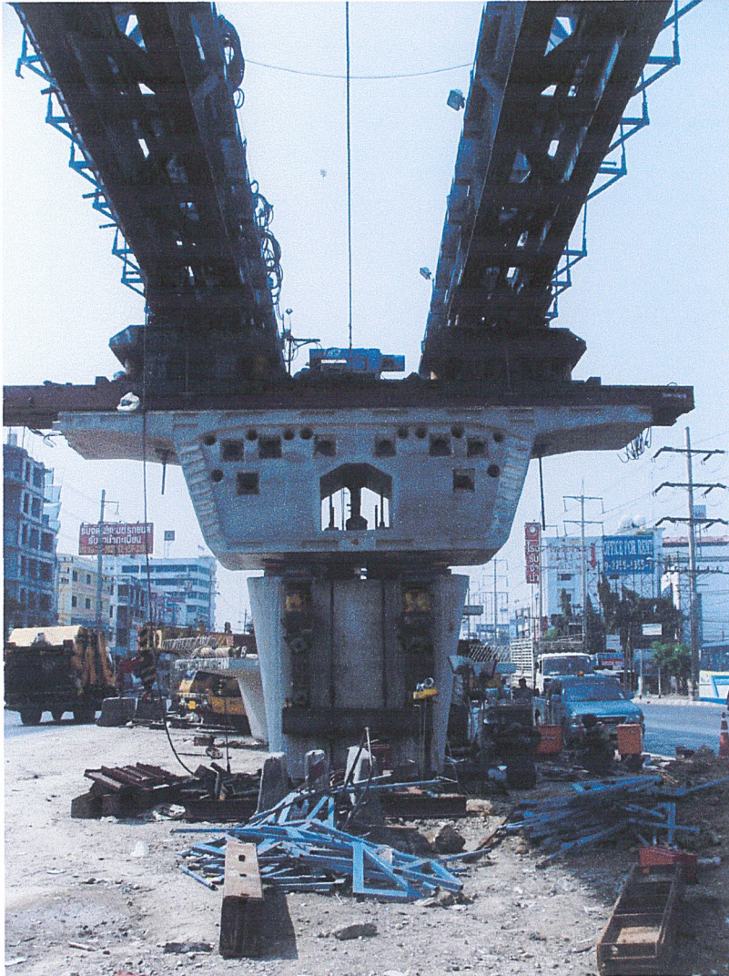
รูปที่ 9.8 แสดงการติดตั้ง Lanching Truss
