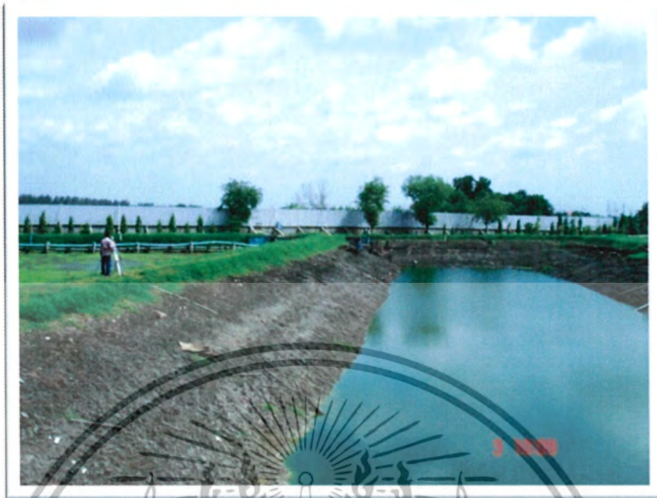
รูปที่ 4-3 แสดงสภาพบ่อน้ำบาดที่ตัดแต่งลาดดินก่อนที่จะเกิดการวิบัติ (1)
