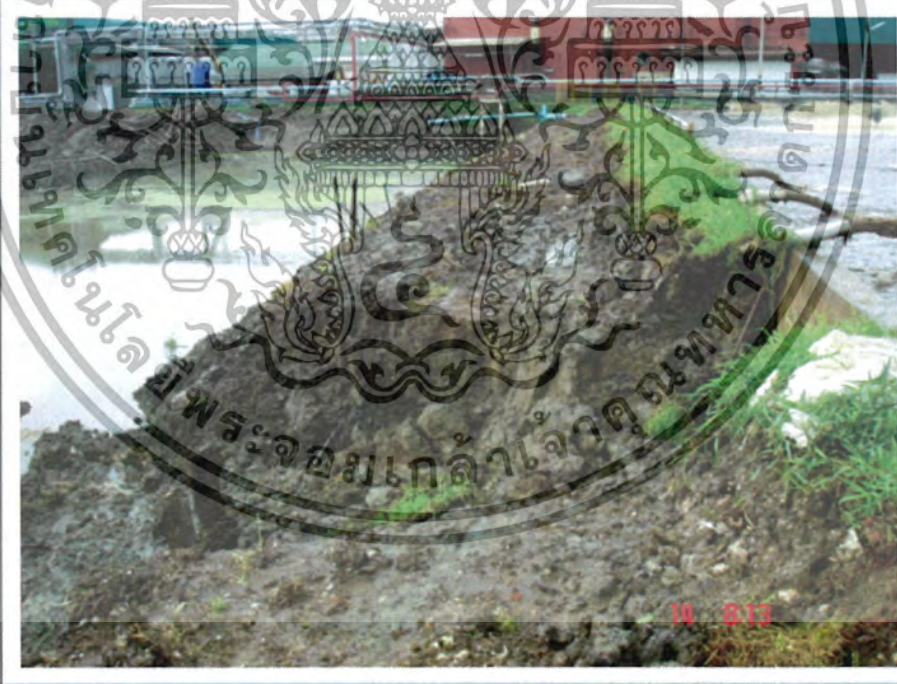
รูปที่ ข - 7 แสดงการวิบัติของลาดดิน
