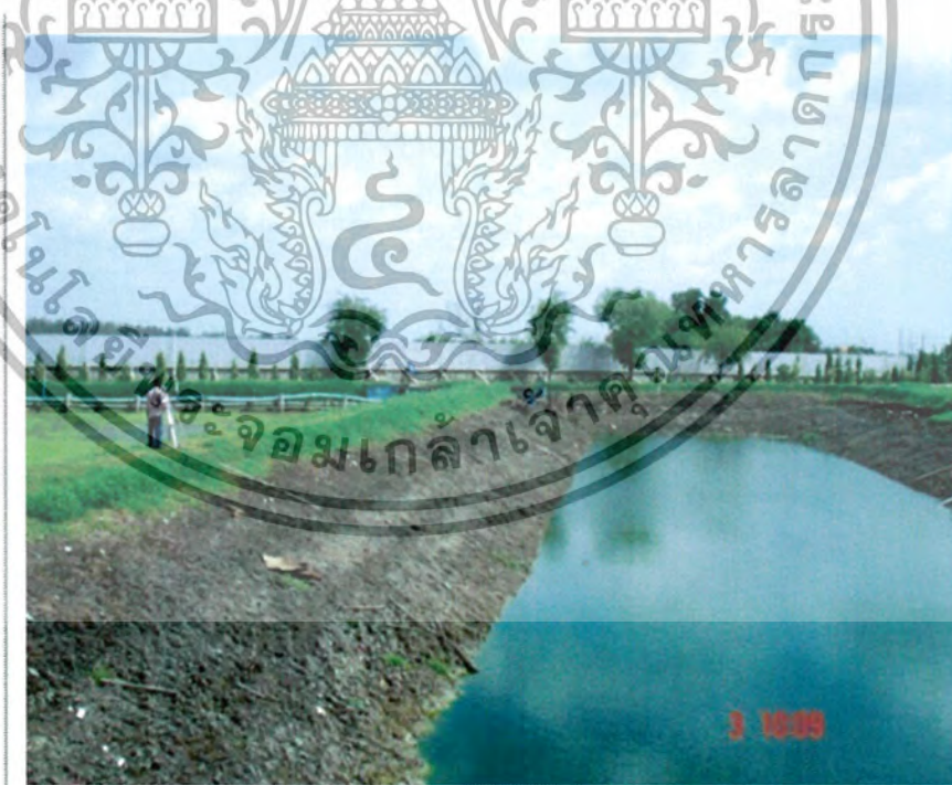
รูปที่ ข - 3 แสดงสภาพบ่อน้ำขุดที่ตัดแต่งลาดดินก่อนที่จะเกิดการวิบัติ (1)
