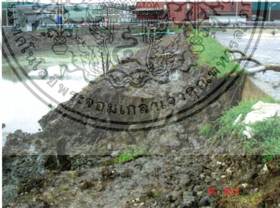
รูปที่ 4-6 แสดงการวิบัติของลาดดิน (1)
