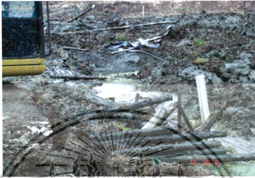
รูปที่ 4-7 แสดงการวิบัติของลาดดิน (2)
