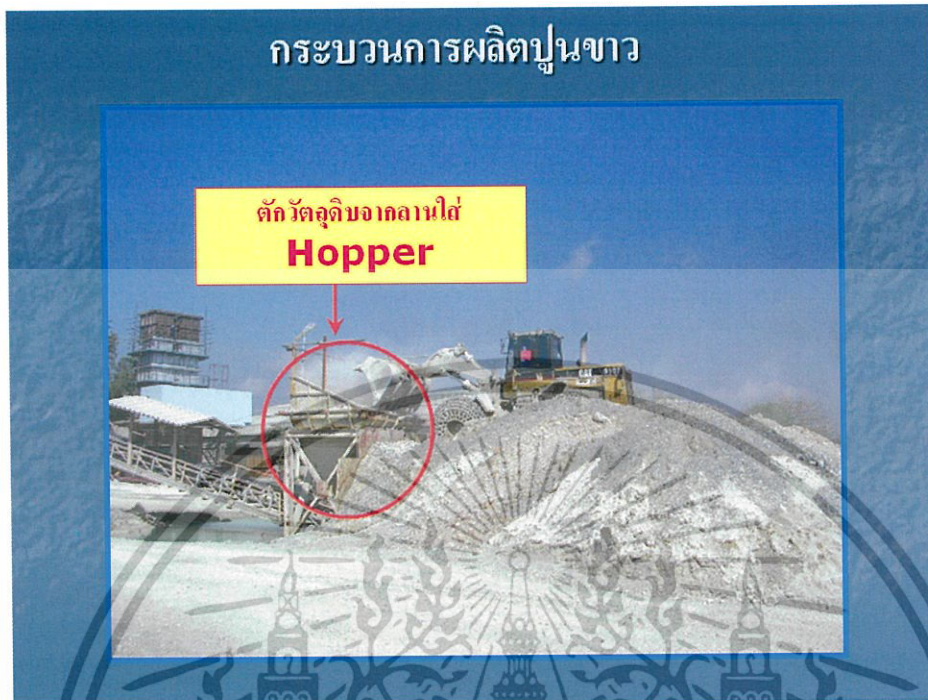
รูปที่ 3.7 การตัดวัสดุดิบเข้า Hopper
