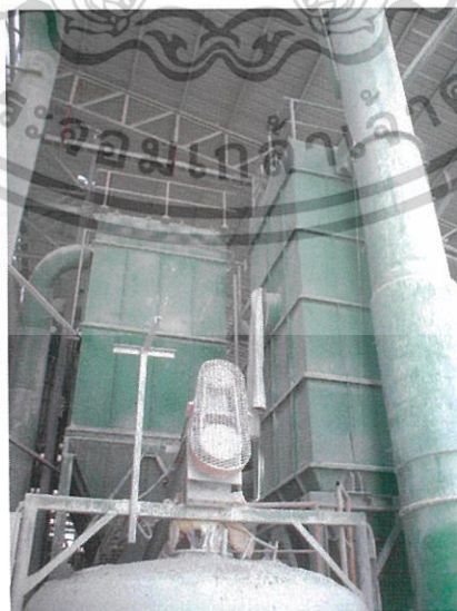
รูปที่ 2.22 ไซโคลนดักฝุ่น (Cyclone Dust Collector)
