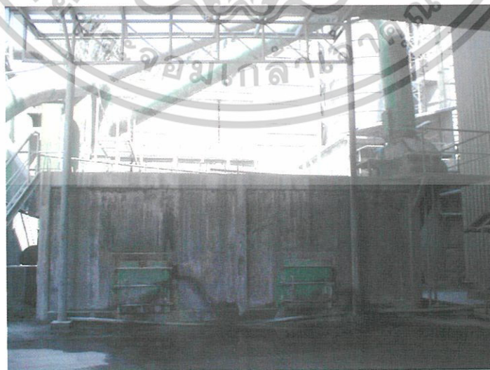
รูปที่ 2.24 สกรับเบอร์แบบเปียก (wet scrubber) ภายในโรงงาน
