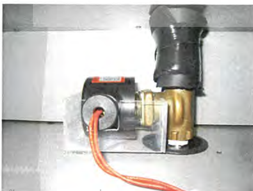
รูปที่ 7 การติดตั้งวาล์วโซเลนอยด์
