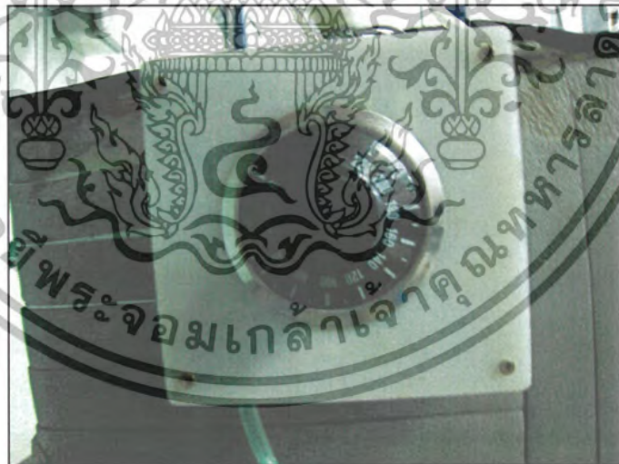
รูปที่ 3-17 แสดงการตั้งเทอร์มอสแตตของหม้อต้มที่ 105 องศาเซลเซียส
