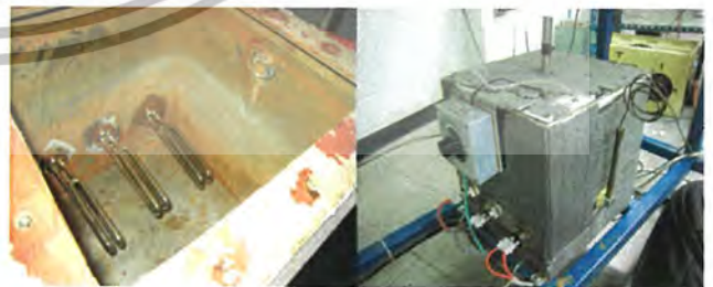
รูปที่ 9 การติดตั้งและซ่อมบำรุงเครื่องกำเนิดไอน้ำ
