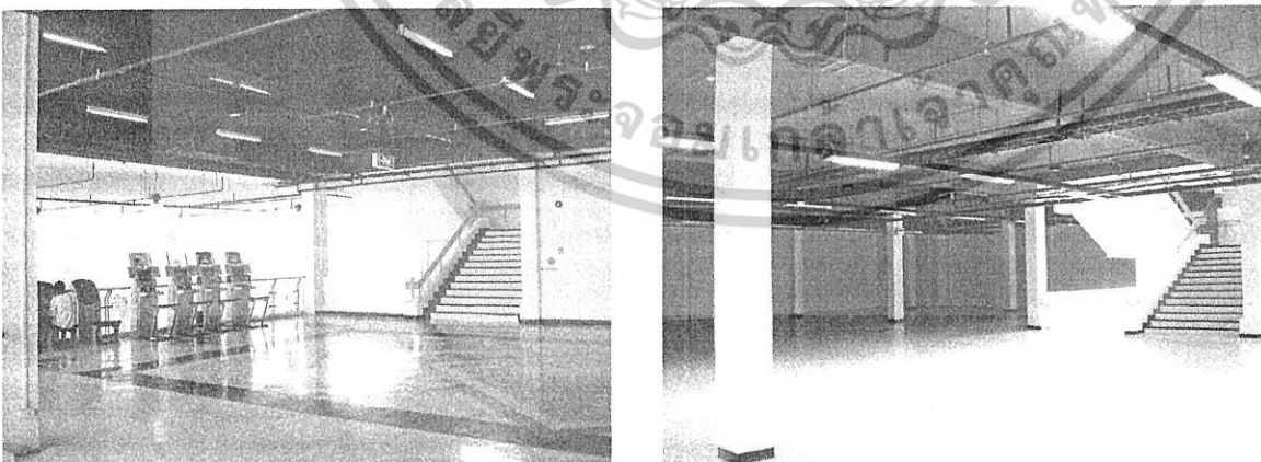
ภาพที่ 5.2 โครงสร้างทั่วไปภายในอาคาร
