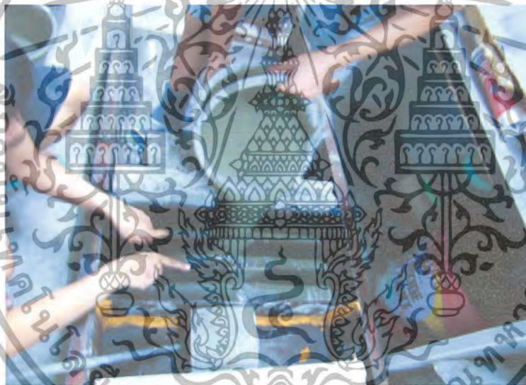
รูปที่ 3.21 เทคอนกรีตมวลเบาที่ผสมเสร็จลงในแบบหล่อ
