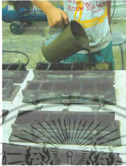
รูปที่ 3.17 เทคอนกรีตมวลเบาที่ผสมเสร็จลงในแบบหล่อ
