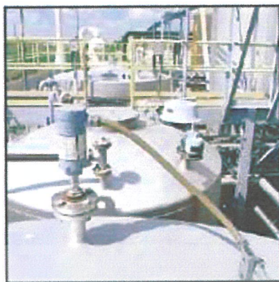
ภาพที่ 3.14 แสดงการติดตั้ง Level Transmitter ที่ถัง
