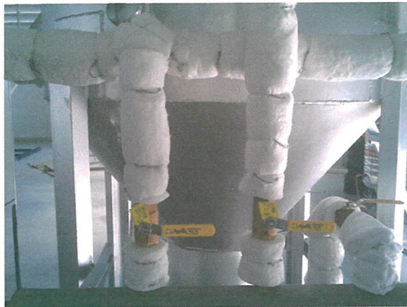
รูปที่ 4.12 ท่อที่เดินไว้สำหรับป้อนไอน้ำเข้าสู่ท่อสเปร์ยวงแหวนภายในแก๊สซิฟายเออร์
