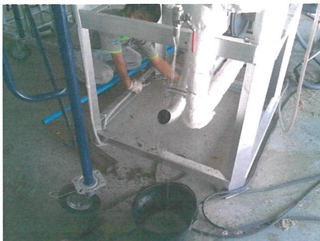
รูปที่ 5.3 การเปิดวาล์วปล่อยน้ำที่ควบแน่นอยู่ในท่อไอน้ำทิ้ง
