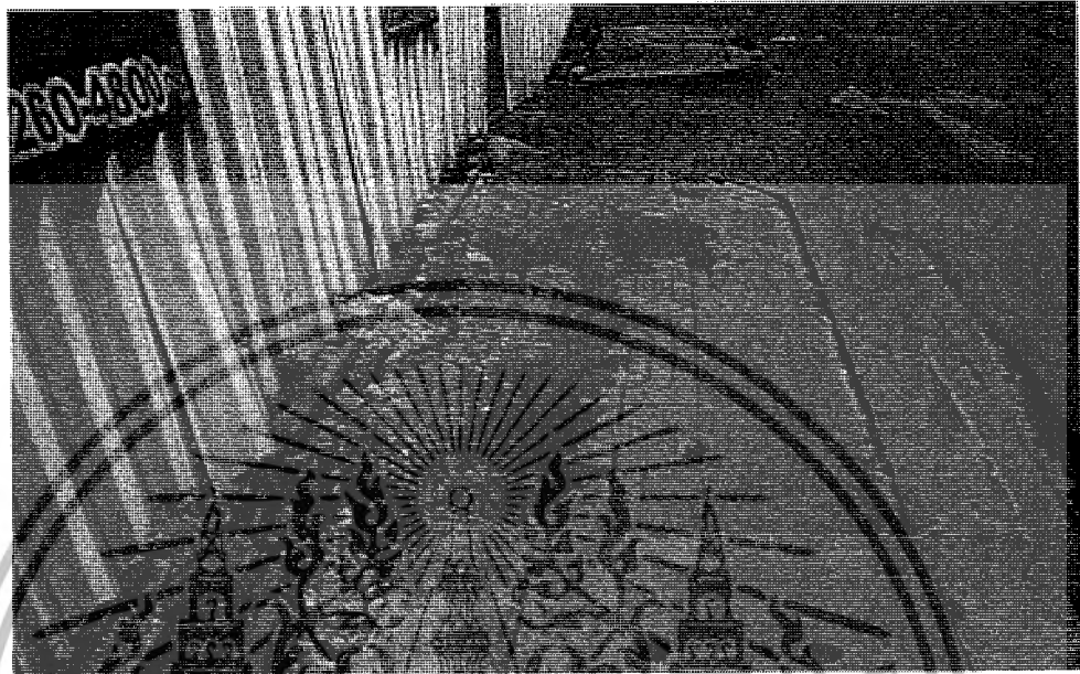
รูปที่ 3.12 ทางเท้าเสียหายเนื่องจากผลกระทบของแรงดันดินด้านข้าง
