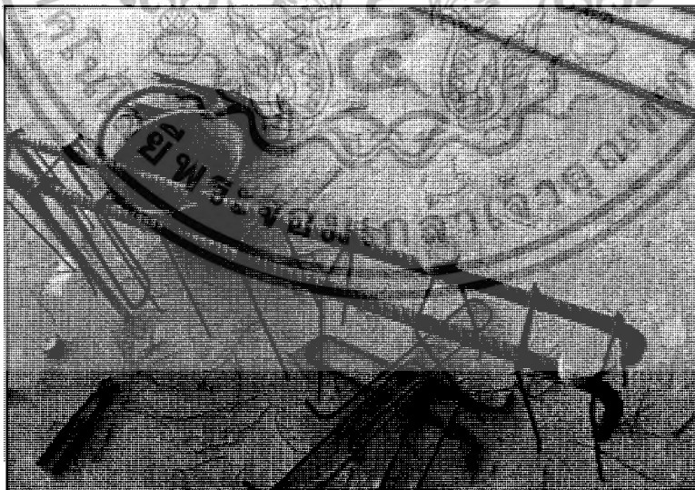
รูปที่ 4.13 การผูกเหล็กปลอก
