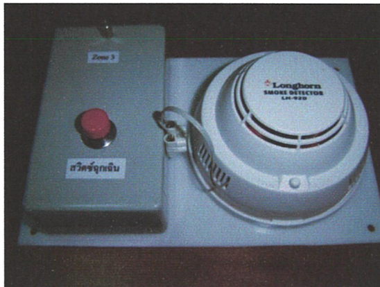
รูปที่ 4.19 การติดตั้งวงจรภาคส่งพร้อมทั้งสโมคคีเทคเตอร์
