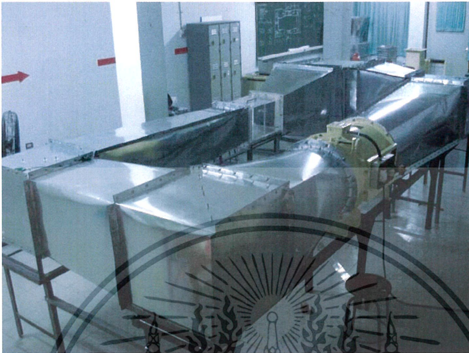
รูปที่ 4-9 การประกอบอุโมงค์ลม
