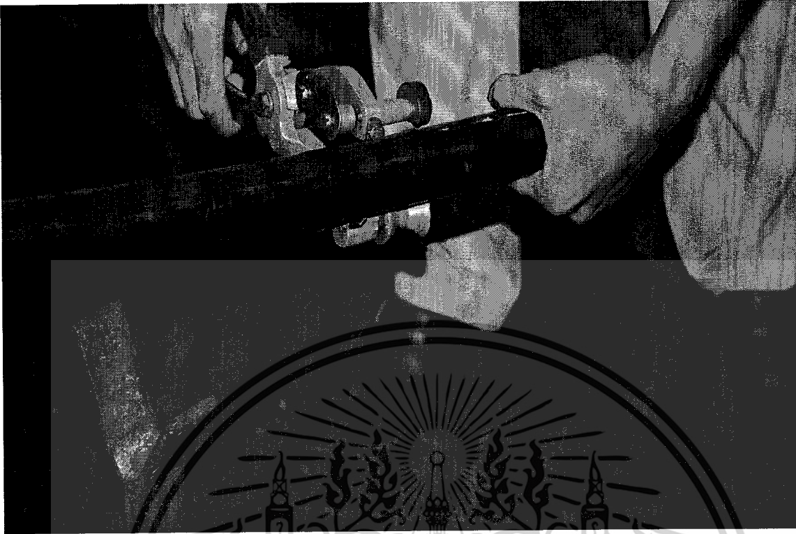
[ก] ขั้นตอนการปอกเปลือกนอก (Jacket) ของสายเคเบิล
