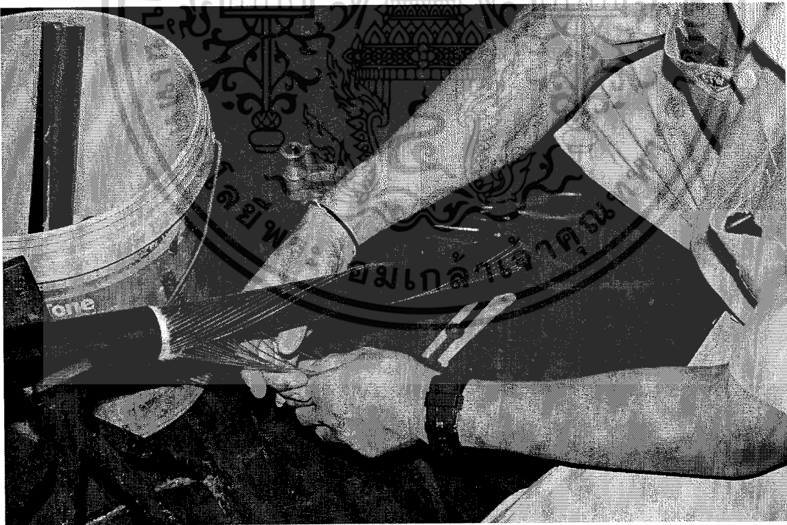
[ง] การเก็บสายกราวด์ของเคเบิลเพื่อเตรียมการทดสอบ
