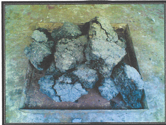
รูปที่3-1 แอสฟัลท์คอนกรีตชำรุด
