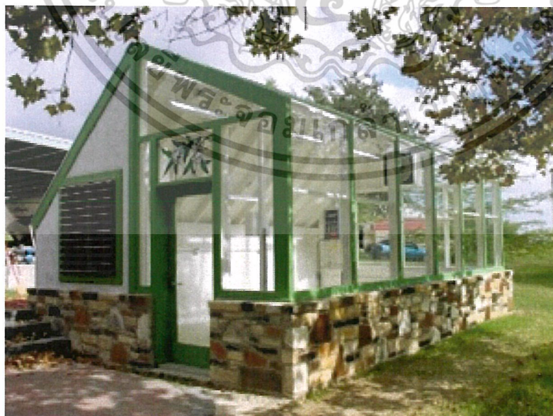
รูปที่ 2.4 โรงเรือนหลังคาหน้าจั่วแบบไม่สมมาตร (Uneven span)
