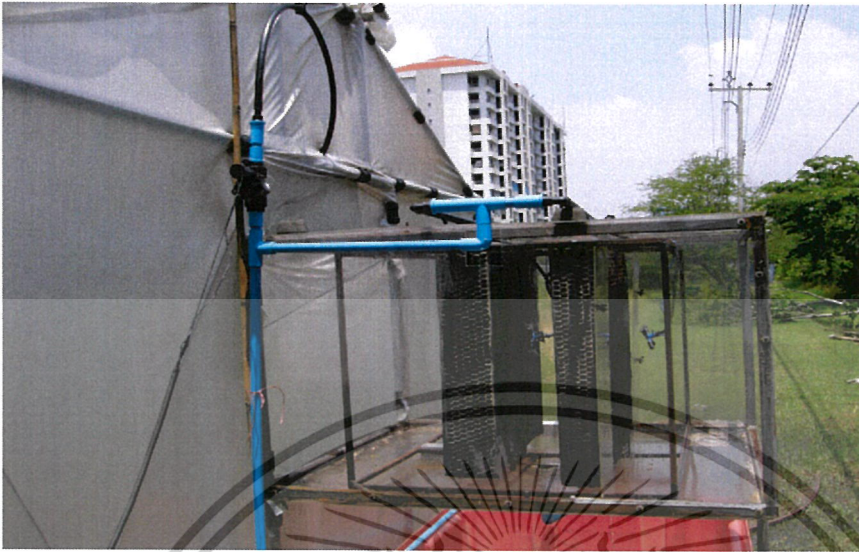
รูปที่ 3.2 ช่องเปิดของโรงเรือนที่มีแผงหม้อน้ำและหัวพ่นฝอยละอองติดตั้งด้านบน
