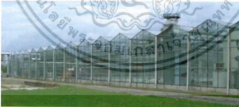
รูปที่ 2.8 โรงเรือนหลังคาต่อเนื่อง (Ridge and furrow)
