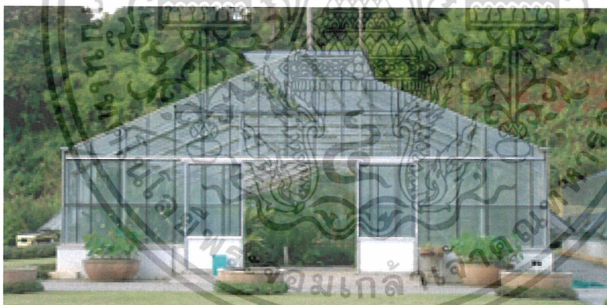
รูปที่ 2.2 โรงเรือนหลังคาหน้าจั่วแบบสมมาตร (Even span หรือ single span)
