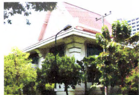
ภาพที่ 1.5 รูปด้านอาคารทางด้านทิศตะวันตก
