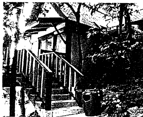
ภาพที่ 2.52 ห้องพักต่อเนื่องจากถนนภายในโครงการ ลักษณะเป็นอาคารเดี่ยวจากบันไดทางขึ้น เป็นระเบียงหน้าห้องสำหรับนั่งพักผ่อน
