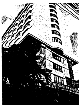
ภาพที่ 3.12 ลักษณะอาคารด้านทิศใต้ ซึ่งติดกับถนนสาทรเหนือ
