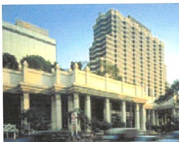
ภาพที่ 2.82 ลักษณะอาคารโรงแรม
