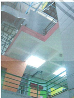
ภาพที่ 1.4 ลักษณะของโถงกลางของอาคารมีสะพานเหล็กเชื่อมใน แต่ละชั้น
