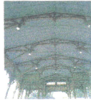
ภาพที่ 153 ลักษณะเพดาน โครงสร้างหลังคา
