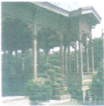
ภาพที่ 151 พระที่นั่งวิมานเมฆ รูปแบบ มุขทำหน้า อาคาร โครงสร้างไม้ฉลุลาย
