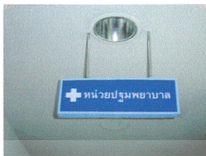
ภาพที่ 2.109 ป้ายแสดงหน่วยปฐมพยาบาลติดตั้งชัดเจน
