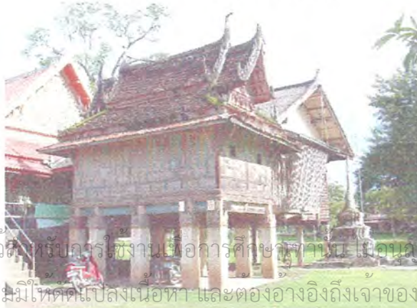
ภาพที่ 3.38 หอไตร วัดท่าเสา
