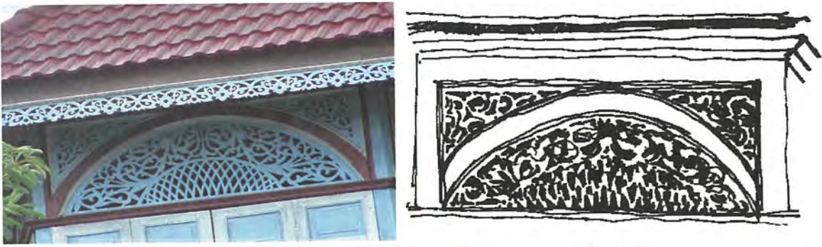
ภาพที่ 4.35 แสดงการลวดไม้ตกแต่งช่องลมด้านบนของมุขด้านหน้าอาคาร การลวดช่องลายนั้นทำให้ในการถ่ายเทจากภายนอกเข้าสู่ภายในได้ง่าย
