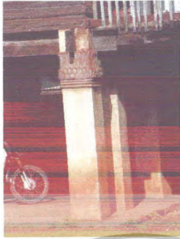
ภาพที่ 3.41 แสดงบัวเสาคานตงของศาลาการเปรียญกับการแกะสลักลวดลายบัวรอบผนังตอนล่าง
