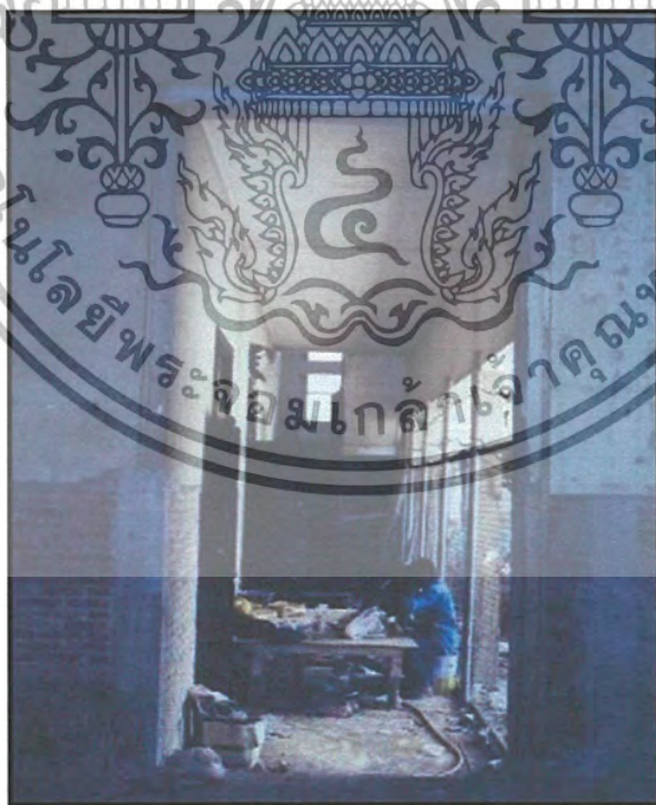
ภาพที่ 3.27 ส่วนจำหน่ายของที่ระลึก ผนัง - คอนกรีต, พื้น - ปูนเรียบ, ประตู - ประตูไม้สำเร็จรูป, กระจก, หน้าต่าง - หน้าต่าง ไม้สำเร็จรูป
