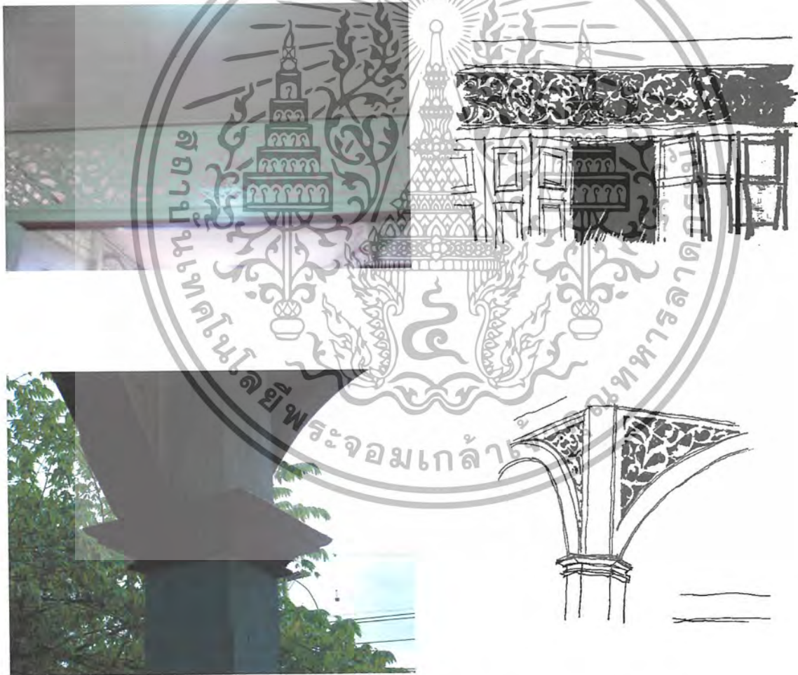
ภาพที่ 4.36 เสาตอนล่างเป็นเสาตีนช้าง ฝาโดยรอบตีแบบบังใบทับ
