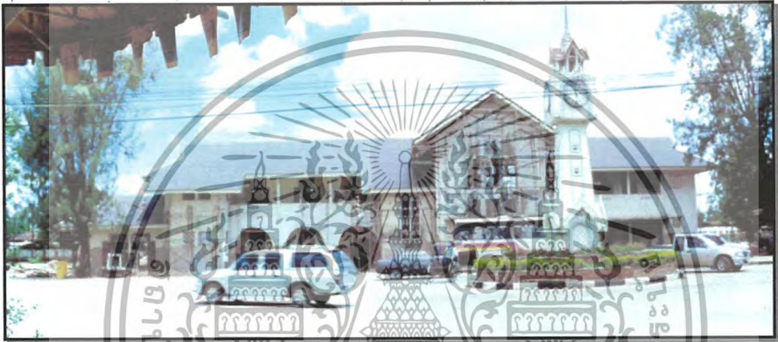
ภาพที่ 3.19 รูปด้านทางตะวันออก ผนัง-คอนกรีต ,ประตู-ประตูไม้สำเร็จรูป,กระฉก,หน้าต่าง - หน้าต่าง ไม้สำเร็จรูป
