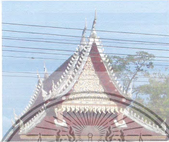
ภาพที่ 3.49 โครงสร้างส่วนหน้าบ้านต่อชายคาช่วงล่าง ในส่วนของเชิงชายเป็นไม้สักทวลาช ทำอย่างประณีต เพิ่มความสวยงามให้กับเครื่องหลังคาได้อย่างมาก
