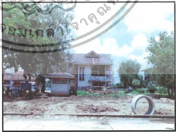
ภาพที่ 3.20 รูปด้านทางทิศเหนือ ผนัง-คอนกรีต ,ประตู-ประตูไม้สำเร็จรูป,กระฉก,หน้าต่าง - หน้าต่าง ไม้สำเร็จรูป
