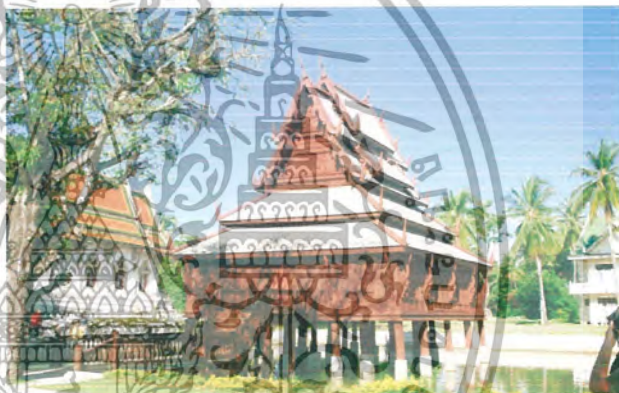
ลักษณะด้านหน้าของหอ ไตรกลาง ลักษณะด้านหน้าของหอไตรส่วนทองหลังคา น้ำที่มีทางเข้าด้านเดียว บานไต่ทำด้วยไม้ทอด ช้อนกิน ตัวอาคารยกสูง ยาวมีราวดูกรงทั้งสองข้าง
