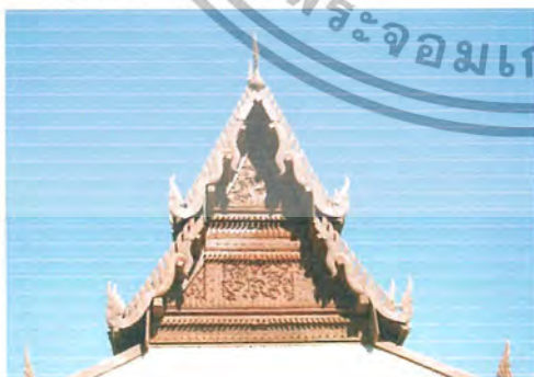
ลักษณะด้านหน้าของหอ ไตรกลาง ลักษณะด้านหน้าของหอไตรส่วนทองหลังคา น้ำที่มีทางเข้าด้านเดียว บานไต่ทำด้วยไม้ทอด ช้อนกิน ตัวอาคารยกสูง ยาวมีราวดูกรงทั้งสองข้าง
