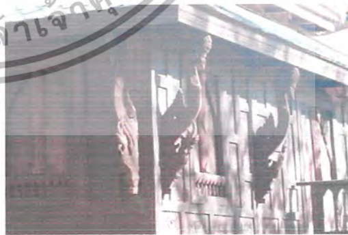
ลักษณะด้านหน้าของหอ ไตรกลาง ลักษณะด้านหน้าของหอไตรส่วนทองหลังคา น้ำที่มีทางเข้าด้านเดียว บานไต่ทำด้วยไม้ทอด ช้อนกิน ตัวอาคารยกสูง ยาวมีราวดูกรงทั้งสองข้าง
